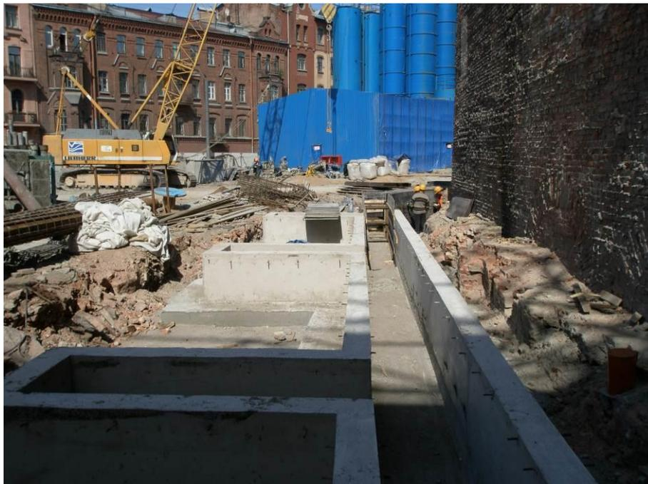
Рисунок 4.3 – Выполненные тавровые захваты, форшахта ещё не демонтирована
