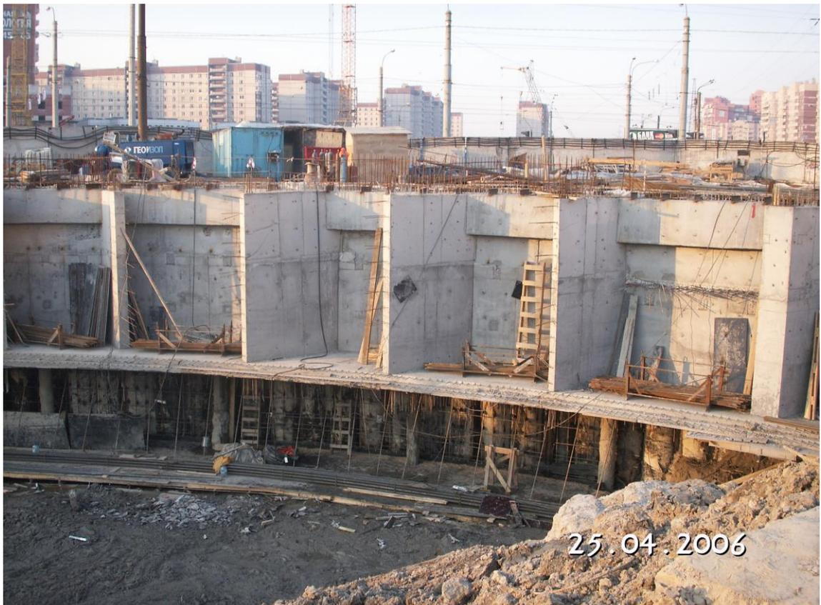
Рисунок 1.4 – Устройство внутренней стены, усиленной горизонтальными рёбрами и вертикальными контрфорсами внутри шпунтового ограждения
