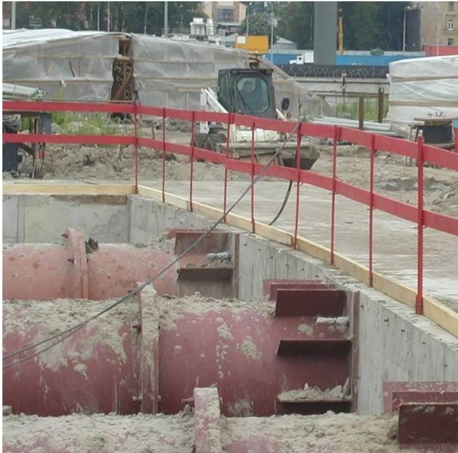
Рисунок 1.7 – Распорные крепления стенок приёмной шахты [45]
