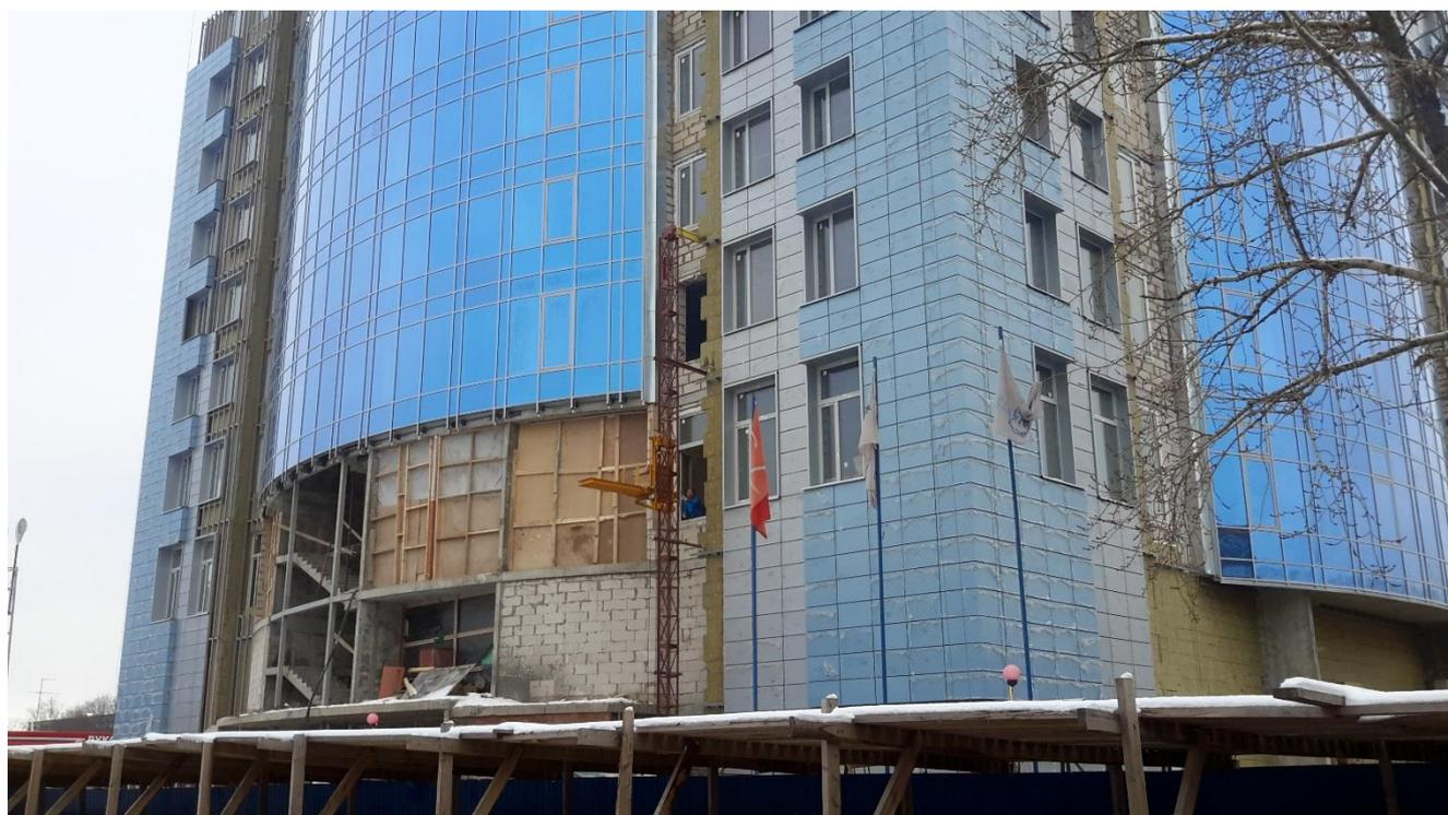
Рисунок 52 – Пример ограждающей стеновой конструкции с использованием НВФ при креплении на межэтажное заполнение из газобетонных блоков (Фотография от 15.01.2016, г. Санкт-Петербург)
