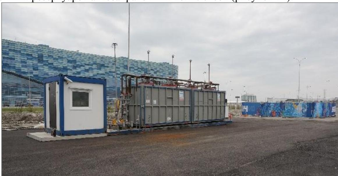
Рисунок 14 – Наземный фиброжелезобетонный резервуар в г. Сочи
