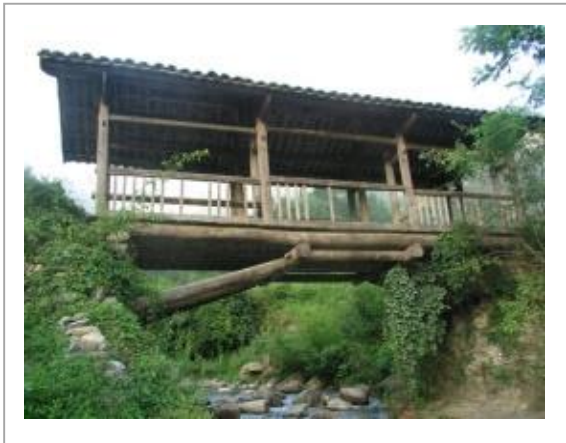
Рис. 3.8. Мост в деревни Дали.
