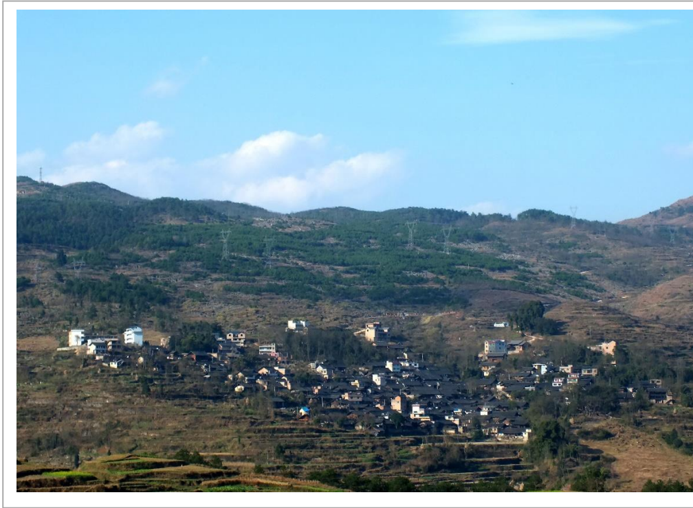
Рис. 3.74. Разрушение целостного облика традиционных сельских
