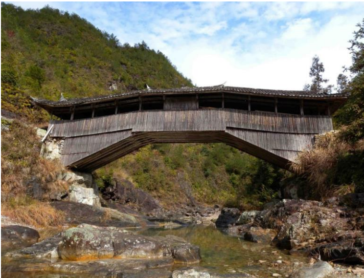
Рис. 3.11. Двусторонняя консоль конструкции.
