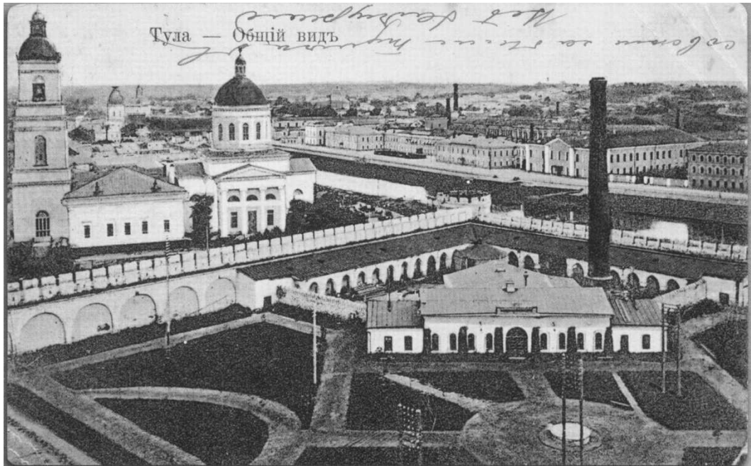
Рисунок Б. 2.9 – вид Наугольной башни и электростанции с колокольни Успенского собора Кремля. Виды г. Тулы нач. XX в.. Тула на старой открытке: альбом/ сост. М. Б. Тенцер, Т., «Борус –Принт», 2012 г., С. 22.
