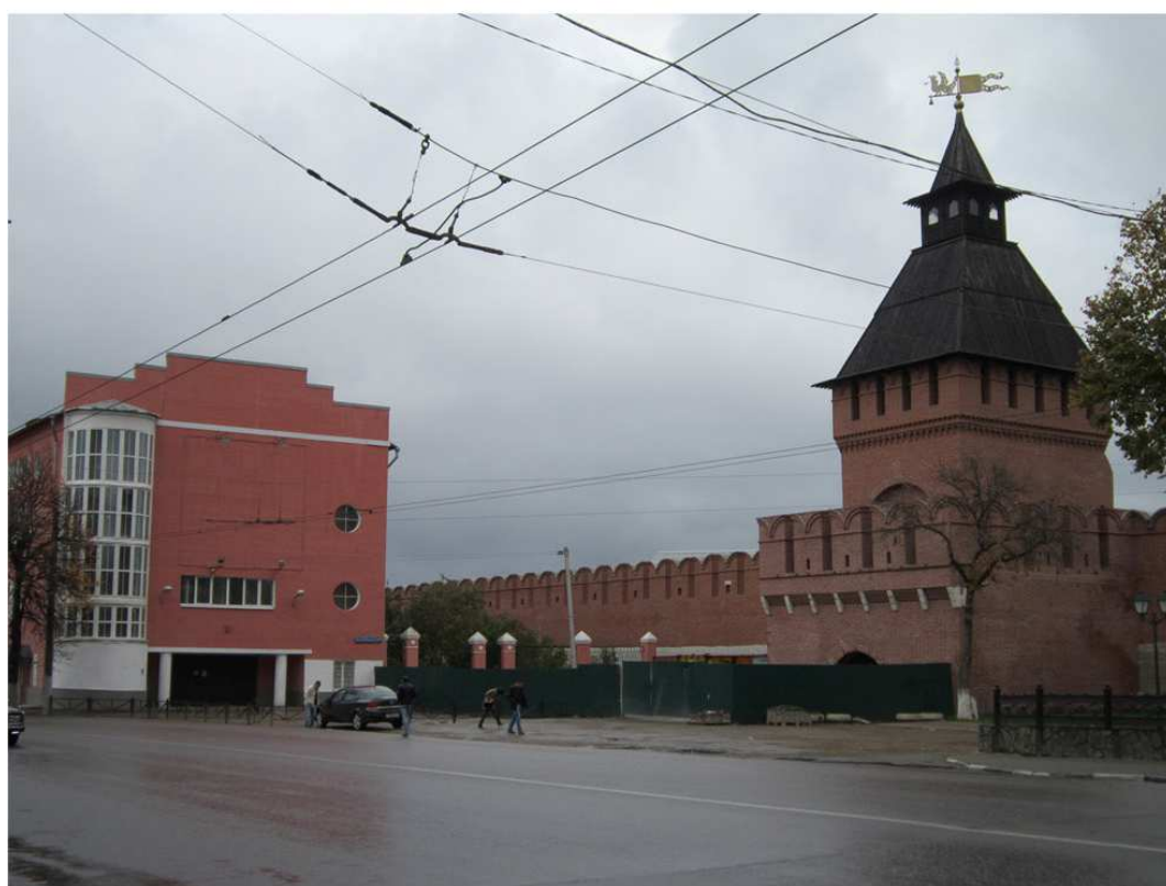
Рисунок Б. 2.45 – Вид здание школы ФЗУ №1. Современное фото.
