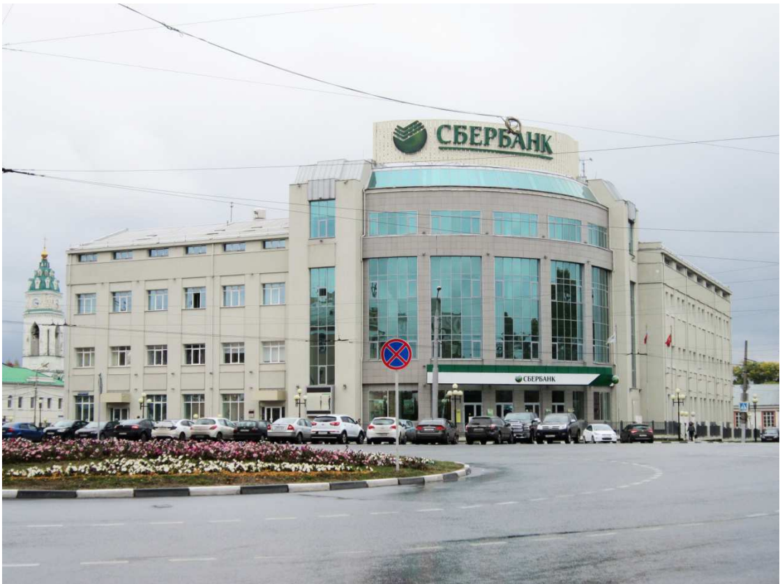
Рисунок Б. 2.53 – здание Тульской фабрики-кухни №1(1929 – 1931 гг., арх. И. Каратыгин). Фото 2015 г.
