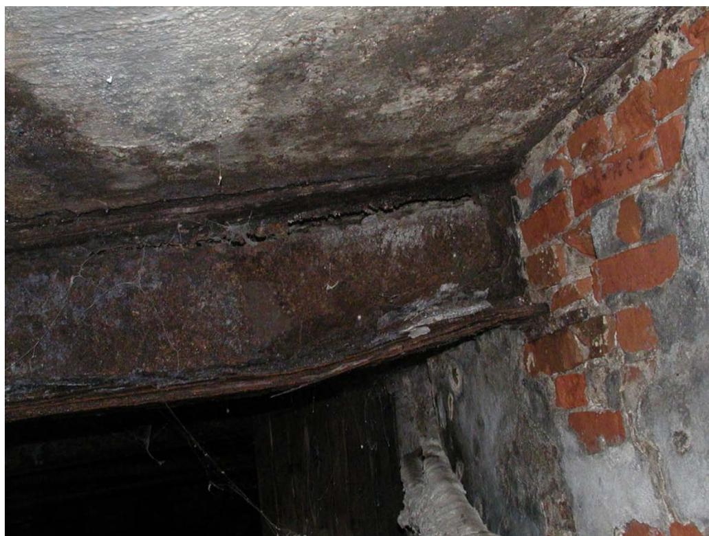
Рисунок 3.38 – Выборг. Крепостная ул., 7. Сплошная язвенная, местами пластинчатая коррозия стальной двутавровой главной балки надподвального перекрытия, прогиб, смятие стенки и полок
