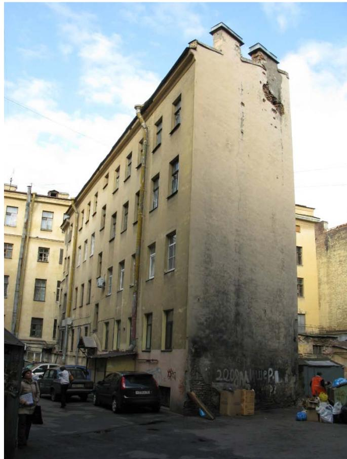
Рисунок 3.21 – Санкт-Петербург. Московский пр., 36 и 40. Трещины и повреждения в кладке в местах прохождения дымовых и вентканалов
