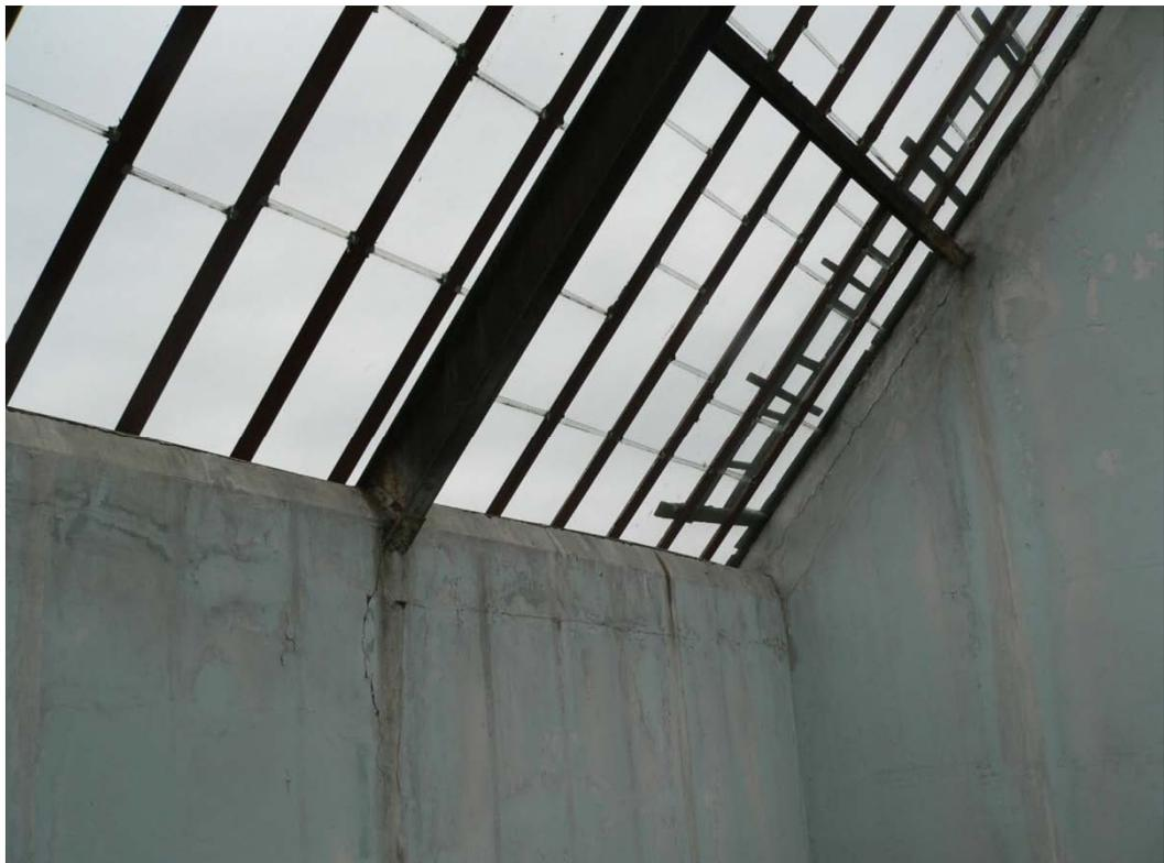
Рисунок 3.18 – Трещины, образовавшиеся вследствие силовых факторов: *a* – Всеволожск, ул. Шишканя, 14; *б* – Сестрорецк, пл. Свободы, д. 4, литер А
