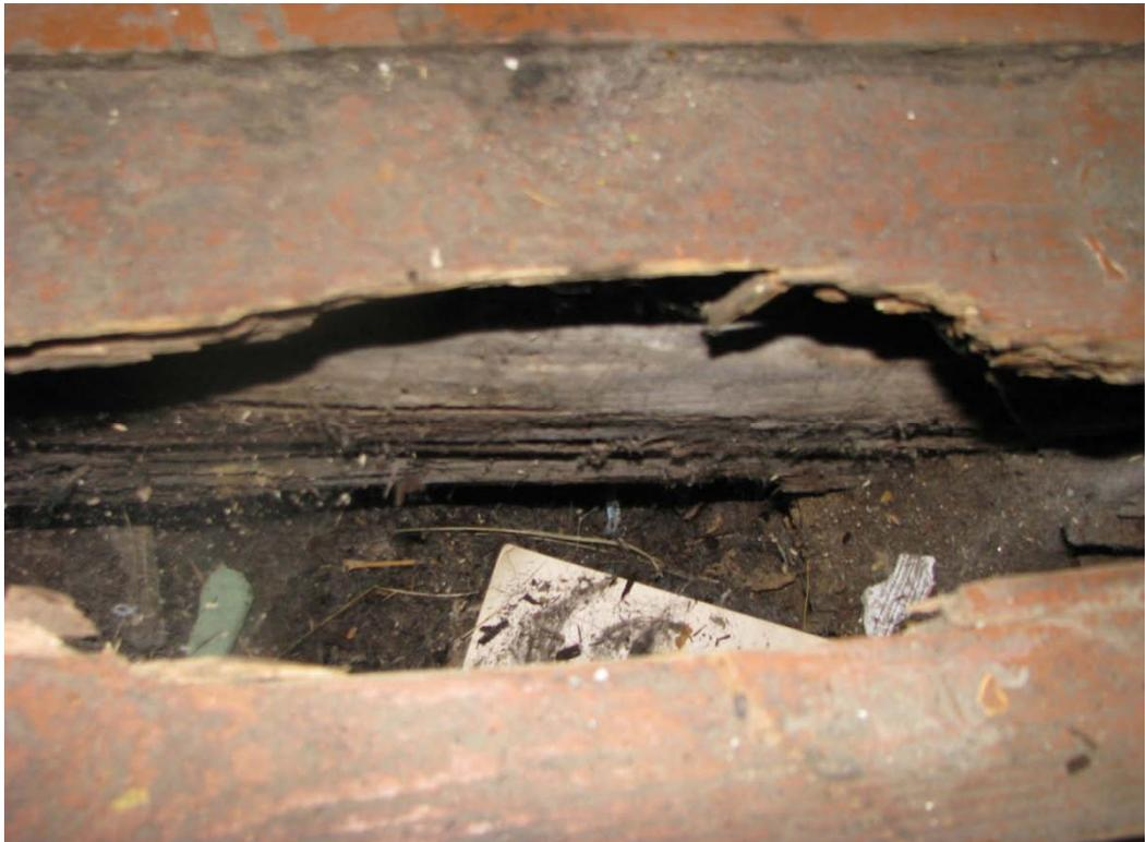
Рисунок 3.44 – Гатчина. Рощинская ул., 38. Вскрытие междуэтажного перекрытия. Видны следы глубокого биопоражения балки
