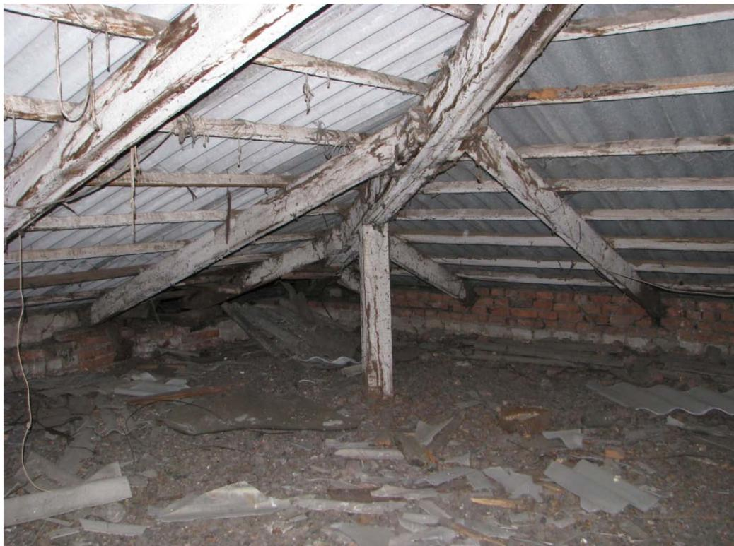
Рисунок 3.46 – Гатчина. Роцинская ул., 38,. Состояние элементов стропильной системы. Виден прогиб диагональной (накосной) стропильной балки
