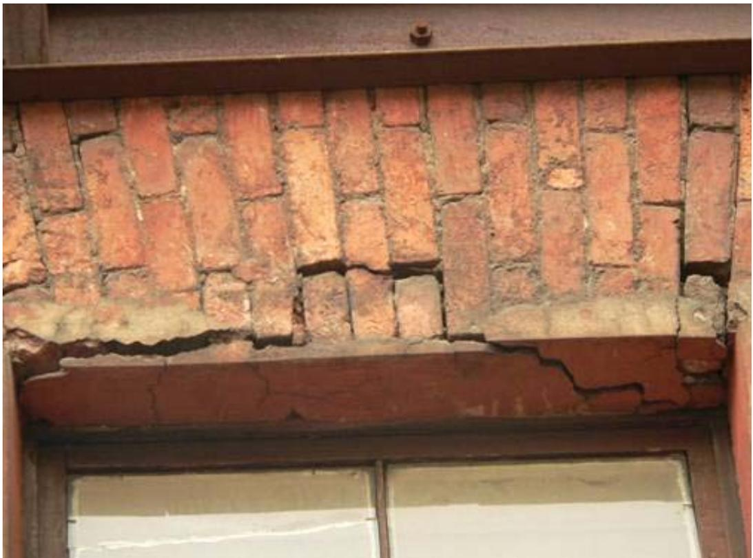
Рисунок 3.19 – Санкт-Петербург. Ул. Чапаева, 7. Трещины, создающие опасность разрушения надоконных перемычек
