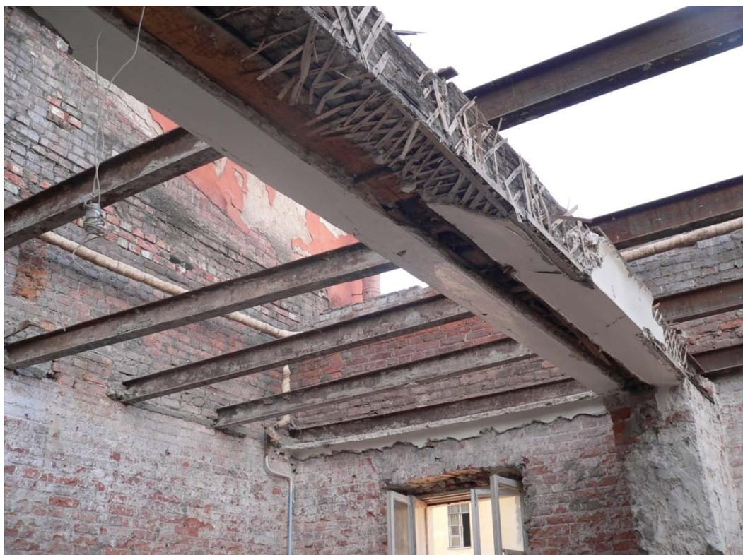
Рисунок 3.36 – Санкт-Петербург. Лиговский пр., 8. Реконструкция детской больницы Раухфуса. Демонтаж перекрытия. Поверхностная коррозия стальных двутавровых балок
