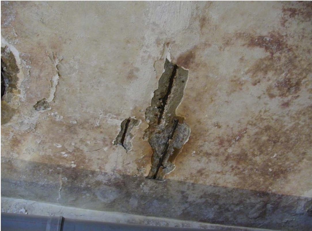
Рисунок 3.29 – Санкт-Петербург. Дегтярная ул., 1. Утрата защитного слоя, обнажение арматуры и коррозия арматурных стержней в главной балке и в плитных участках перекрытия
