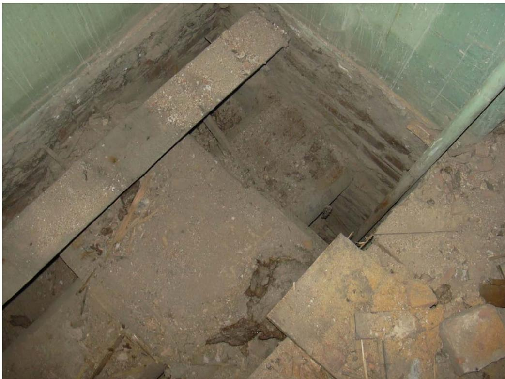
Рисунок 3.35 – Санкт-Петербург. Наб. р. Мойки, 72. Вскрытие перекрытия. Поверхностная коррозия стальной двутавровой балки
