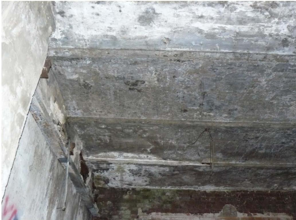
Рисунок 3.33 – Пушкин. Московский пер., 42. Протечки и увлажнение бетона заполнения в виде сводиков надподвального перекрытия, коррозия и прогиб балок
