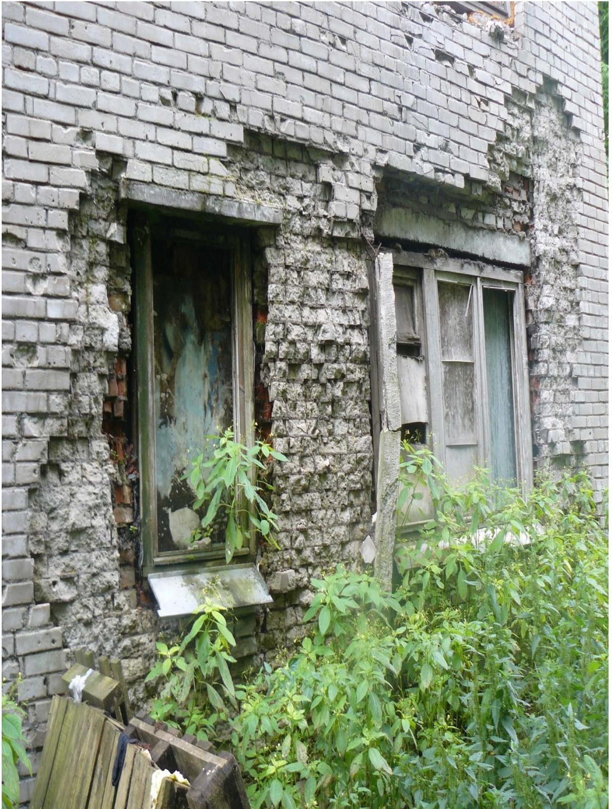
Рисунок 3.11 – Всеволожск. Ул. Шишканя, 14. Вывалы и деструкция кладки стены у оконных проемов дворового фасада
