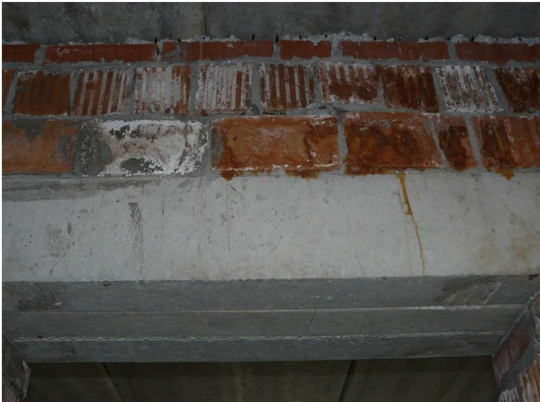
Рисунок 3.28 – Рощино. Ул. Садовая, д.7. Трещины в перемычке дверного проема, нормальные к продольной оси
