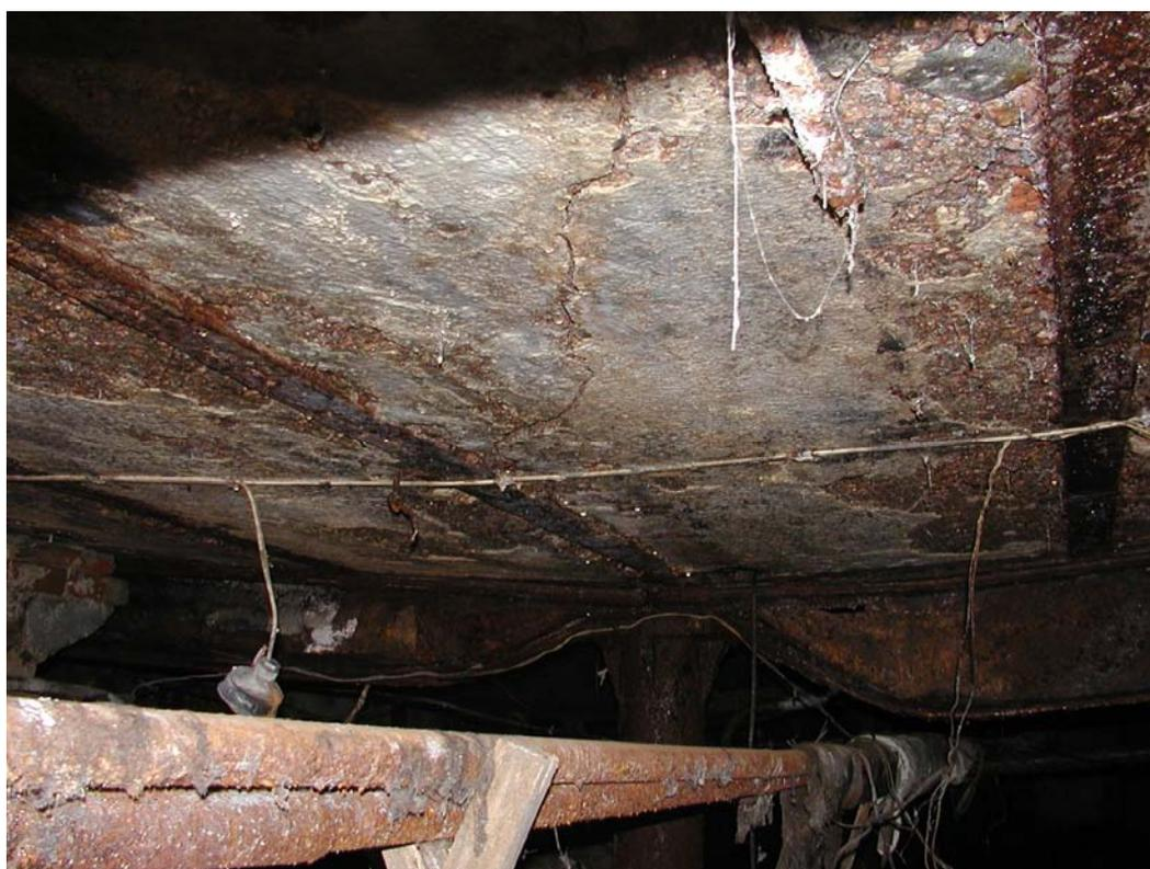
Рисунок 3.40 – Выборг. Крепостная ул., 7. Сплошная язвенная, местами пластинчатая коррозия несущих элементов надподвального перекрытия, визуально фиксируемый прогиб, смятие полок и стенок двутавров в местах опирания на стойки (видна трещина в бетоне заполнения)
