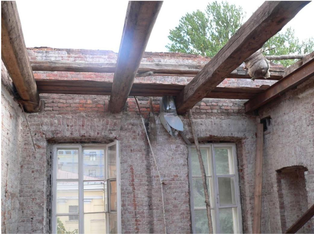
Рисунок 3.45 – Санкт-Петербург. Лиговский пр., 8. Реконструкция детской больницы Раухфуса. Демонтаж перекрытия. Состояние деревянных балок перекрытия. Виден прогиб балок
