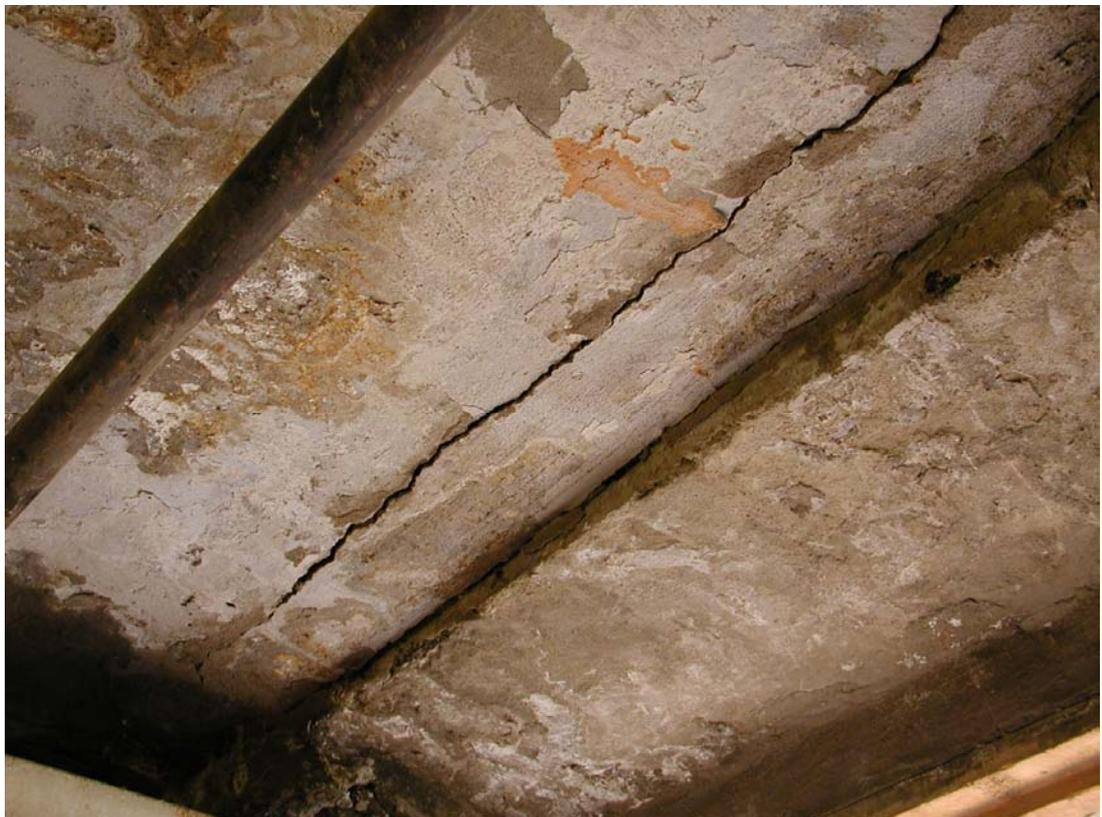
Рисунок 3.24 – Санкт-Петербург. Дегтярная ул.,1. Продольные трещины в защитном слое вдоль арматурных стержней
