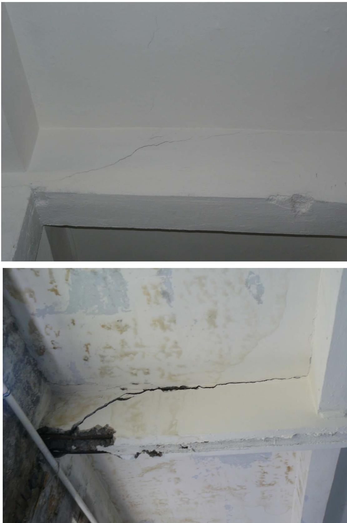
Рисунок 3.26 – Санкт-Петербург. Малый пр., 64, В.О. Наклонные трещины на приопорных участках второстепенных и главных балок перекрытия, утрата защитного слоя и обнажение арматуры (на нижнем снимке – разрушение балки по наклонному сечению)
