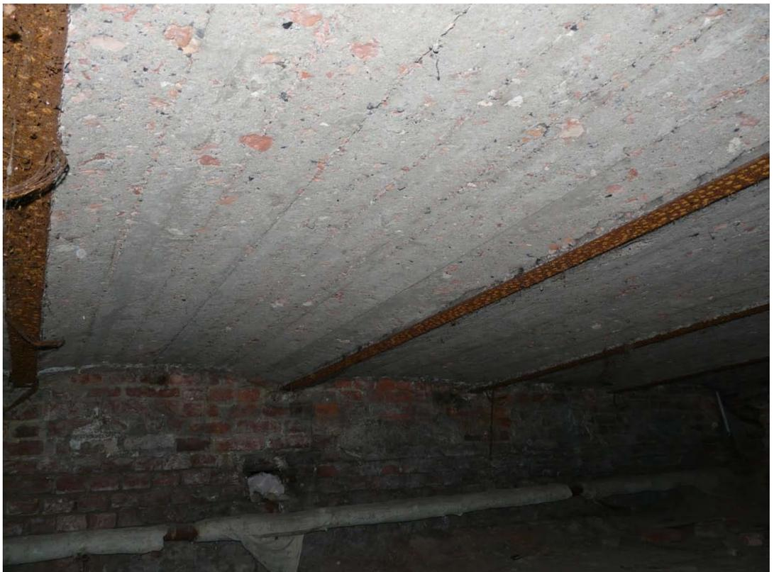
Рисунок 3.42 – Сплошная равномерная коррозия стальных двутавровых балок, разрушение защитного покрытия: *a* – Санкт-Петербург. Наб. р. Мойки, 72; *б* – Санкт-Петербург. Бронницкая ул., 9, литер А3
