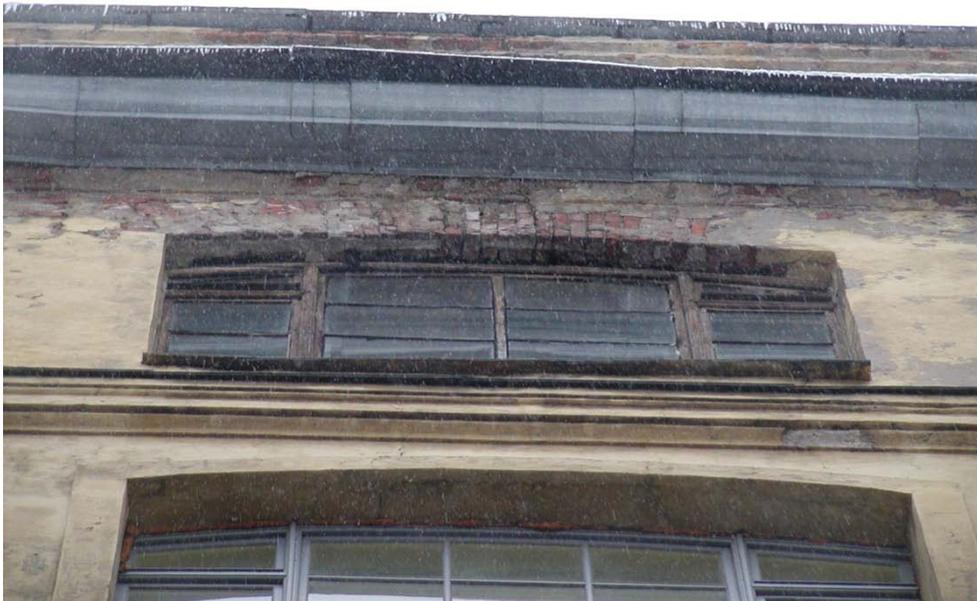
Рисунок 3.6 – Санкт-Петербург. Наб. р. Мойки, 73. Здание ФОСП. Повреждения отделочного слоя в верхней части стены дворового фасада
