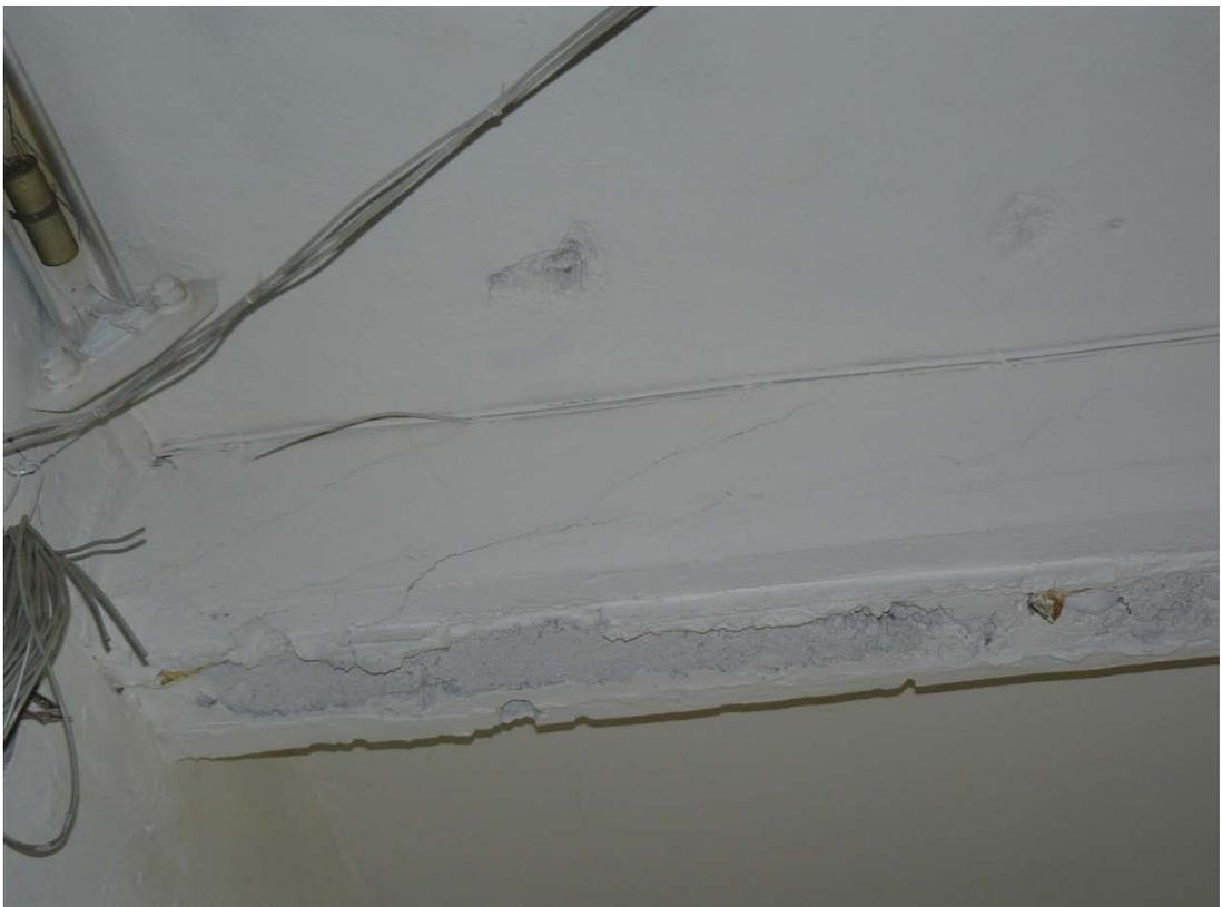
Рисунок 3.25 – Санкт-Петербург. Малый пр., 64, В.О. Наклонные трещины на приопорных участках главных балок перекрытия
