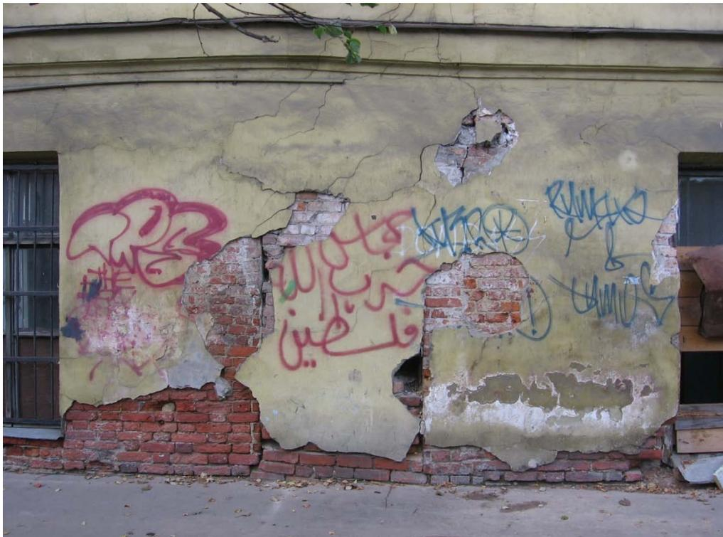
Рисунок 3.10 – Санкт-Петербург. Воронежская ул., 1. Нарушение сплошности, разрушение и деструкция, выпучивание, выбоины и хаотичное трещинообразование в стене лицевого фасада
