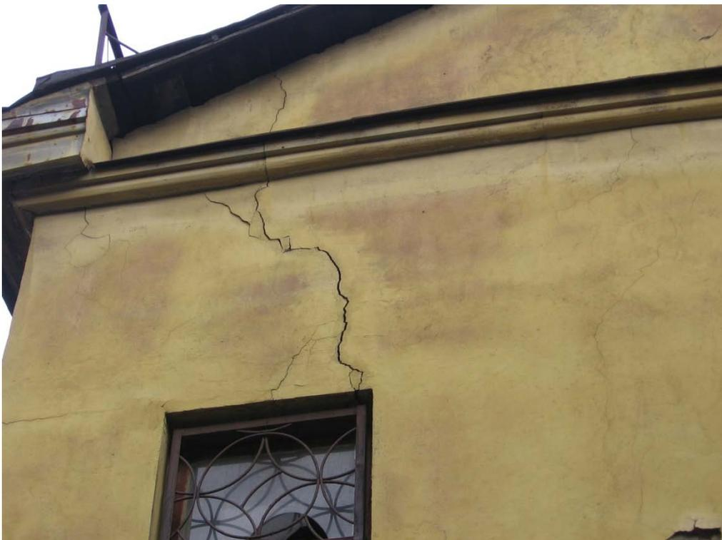
Рисунок 3.15 – Санкт-Петербург. Воронежская ул., 1. Трещины в кладке стены наклонной ориентации (трещины осадочного происхождения, проходят по оконным проемам)
