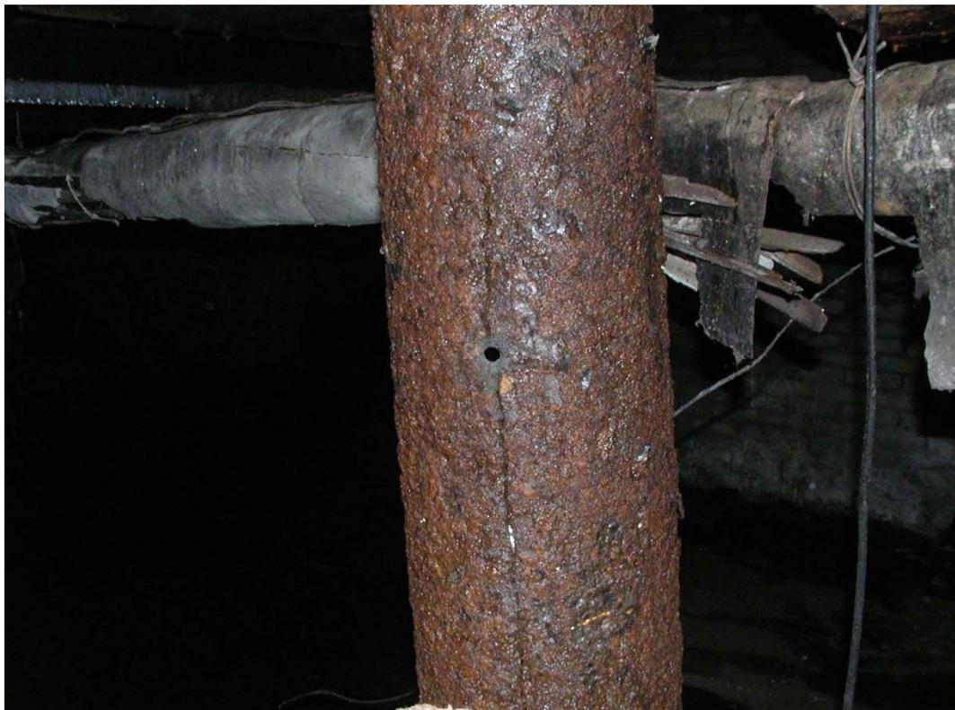
Рисунок 3.41 – Выборг. Крепостная ул., 7. Сплошная язвенная, местами пластинчатая коррозия несущих элементов надподвального перекрытия, смятие полок и стенок двутавровых балок, трещина в стойке (показано отверстие для определения остаточной толщины стенки)
