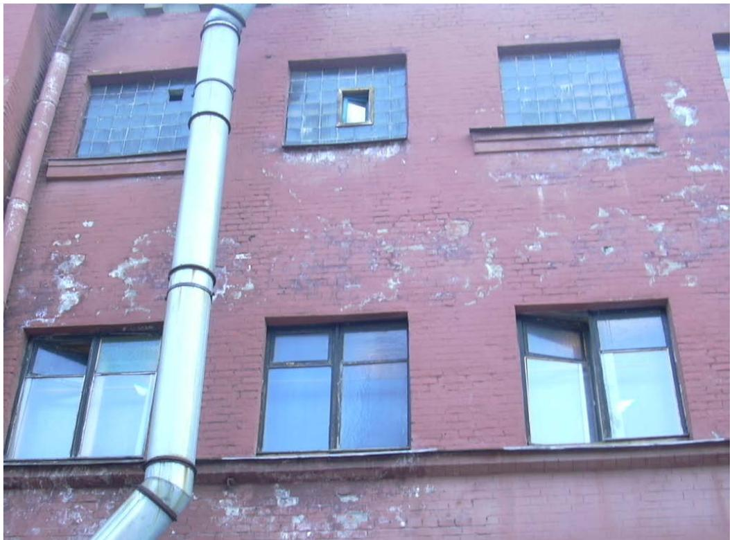
Рисунок 3.14 – Санкт-Петербург. Ярославский пр., 16. Увлажнение и замачивание, вымывание и выветривание, высолы на поверхности кладки стены дворового фасада
