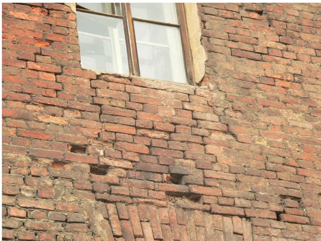
Рисунок 3.9 – Санкт-Петербург. Ул. Чапаева, 7. Нарушение сплошности кладки в межоконном поясе стены дворового фасада
