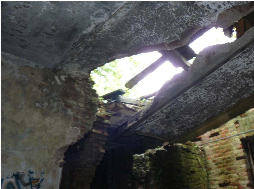
Рисунок 3.34 – Пушкин. Московский пер., 42. Разрушение бетона заполнения надподвального перекрытия
