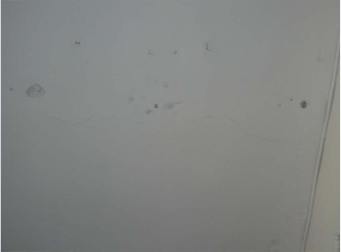
Рисунок 3.27 – Санкт-Петербург. Малый пр., 64, В.О. Трещины в плитных участках монолитного железобетонного перекрытия
