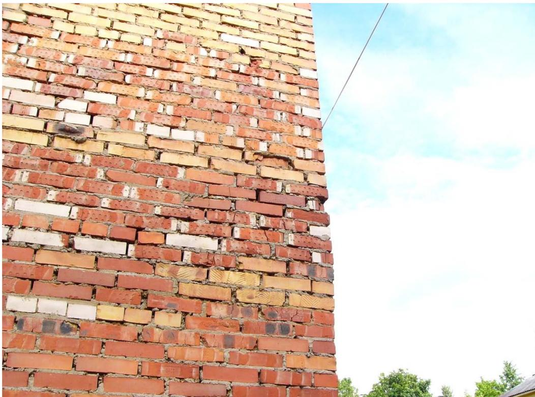
Рисунок 3.13 – Гатчина. Ул. Чкалова, 18, литер А1. Отклонения углов здания от вертикали
