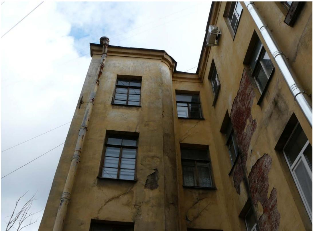
Рисунок 3.17 – Санкт-Петербург. 12-я Красноармейская, 12. Трещины в кладке стены наклонной ориентации (трещины осадочного происхождения, проходят по оконным проемам)
