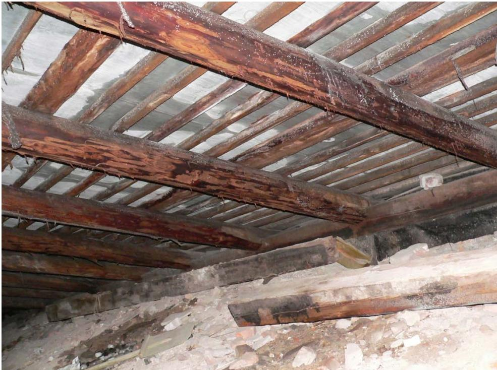
Рисунок 3.47 – Санкт-Петербург. Ул. Чапаева, 7. Состояние элементов стропильной системы. Видны следы увлажнения и поверхностного биопоражения стропильных балок и мауэрлата
