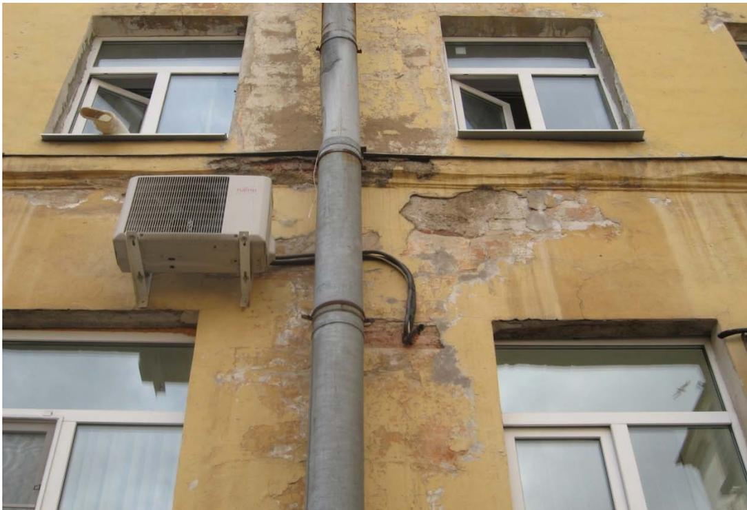
Рисунок 3.7 – Санкт-Петербург. Басков пер., 5. Повреждения отделочного слоя в местах расположения водосточных труб (повреждения по всему простенку)
