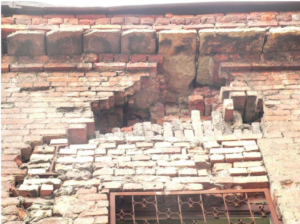
Рисунок 3.12 – Санкт-Петербург. Ул. Чапаева, 7. Нарушение сплошности, деструкция, вывалы и разрушение кладки стены дворового фасада
