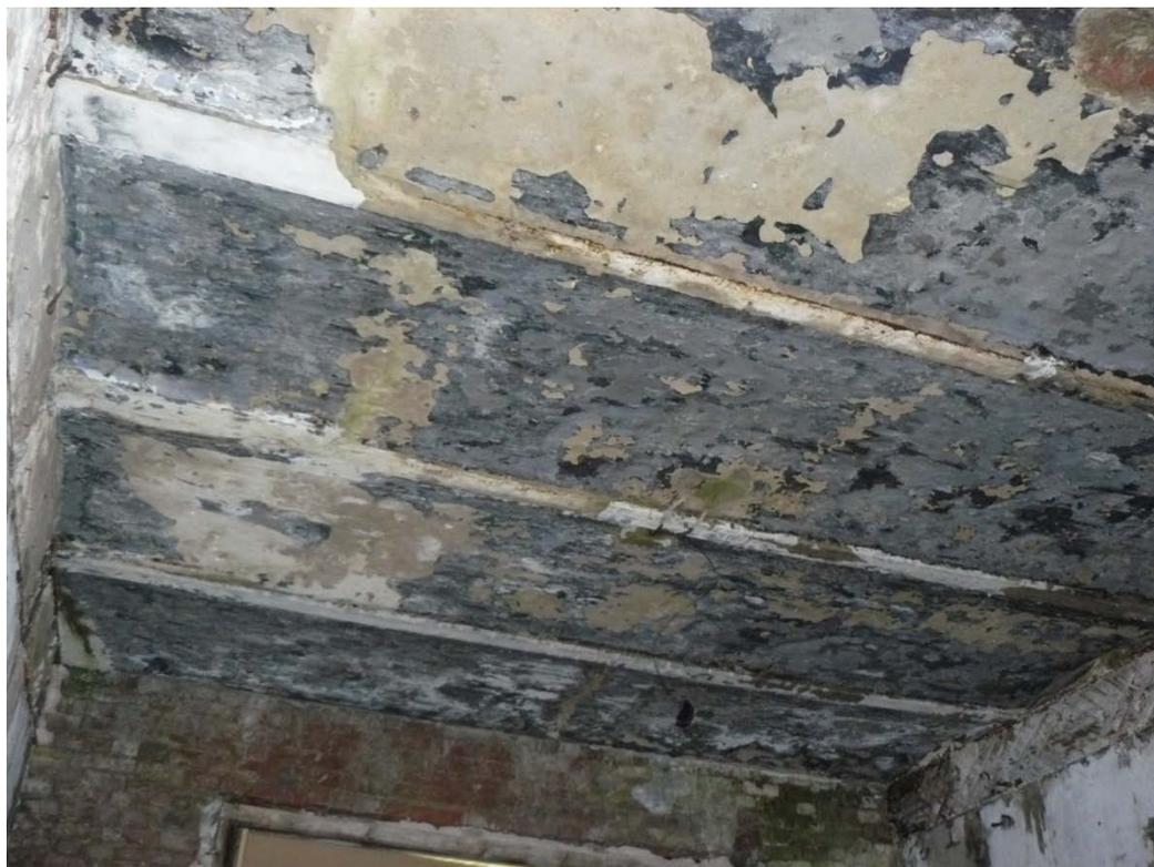
Рисунок 3.37 – Пушкин. Московский пер., 42. Сплошная равномерная язвенная коррозия стальных двутавровых балок
