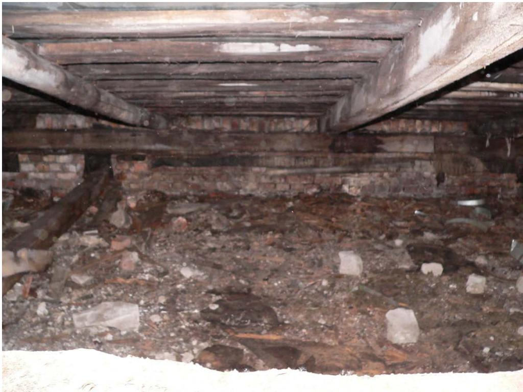
Рисунок 3.49 – Санкт-Петербург. Ярославский пр., 16. Состояние элементов стропильной системы. Видны следы увлажнения и поверхностного биопоражения всех элементов, прогиб и трещины усушки
