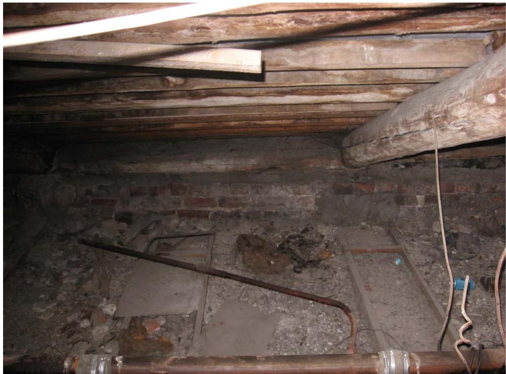
Рисунок 3.48 – Санкт-Петербург. Ул. Эсперова,7. Состояние элементов стропильной системы. Видны следы увлажнения и поверхностного биопоражения стропильных балок и мауэрлата в местах их опирания, трещины усушки
