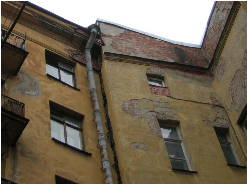
Рисунок 3.5 – Санкт-Петербург. Шпалерная ул., 26. Повреждения отделочного слоя в верхней части стены дворового фасада (на верхнем снимке видна магистральная трещина осадочного происхождения)
