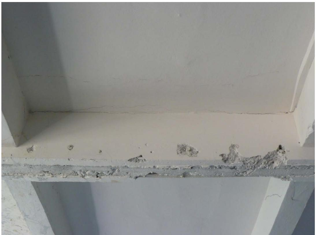
Рисунок 3.23 – Санкт-Петербург. Малый пр., 64, В.О. Поверхностные повреждения конструктивных элементов балочной клетки перекрытия. На верхнем снимке виден прогиб второстепенной балки
