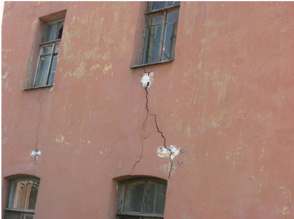
Рисунок 3.16 – Санкт-Петербург. Ул. Эсперова, 7. Трещины в кладке стены наклонной ориентации (трещины осадочного происхождения, проходят по оконным проемам) и трещины, создающие опасность разрушения надоконных перемычек
