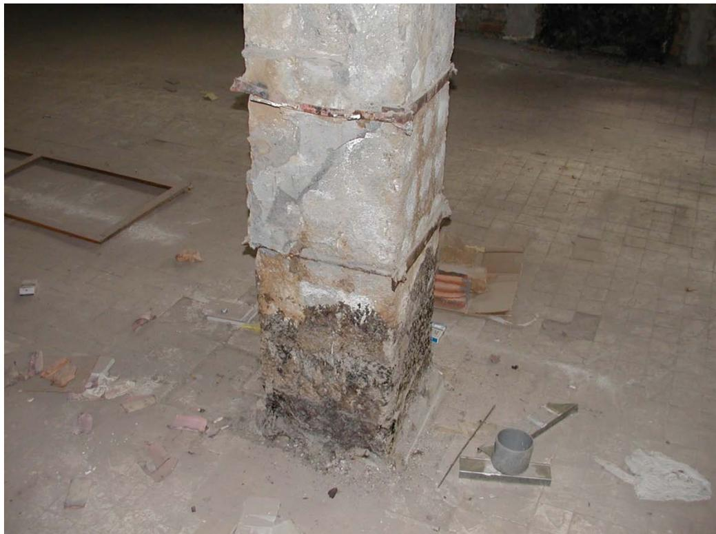
Рисунок 3.30 – Санкт-Петербург. Дегтярная ул., 1. Утрата защитного слоя, обнажение арматуры и коррозия арматурных стержней в колоннах
