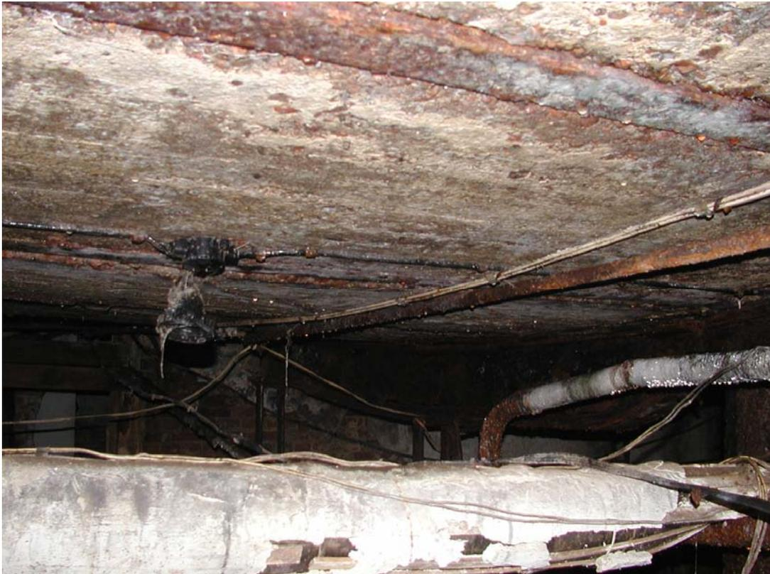
Рисунок 3.39 – Выборг. Крепостная ул., 7. Сплошная язвенная, местами пластинчатая коррозия стальных двутавровых второстепенных балок надподвального перекрытия, визуально фиксируемый прогиб
