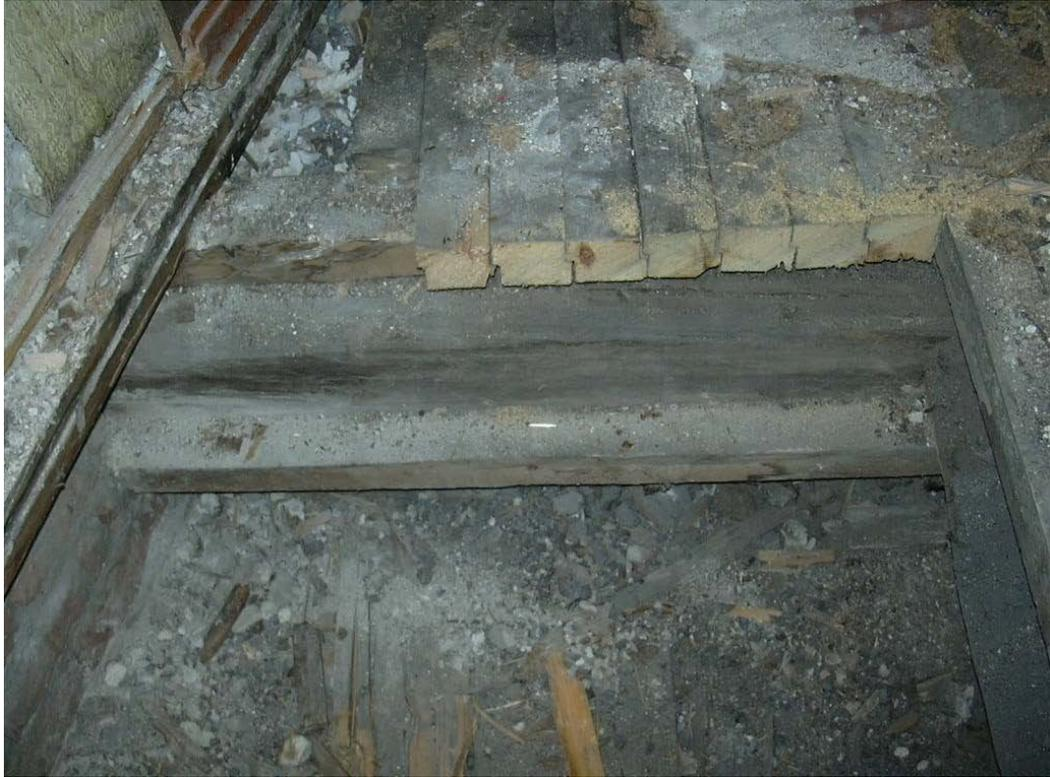
Рисунок 3.43 – Санкт-Петербург. Наб. р. Мойки, 72. Вскрытие междуэтажного перекрытия. Видны следы поверхностного биопоражения балки
