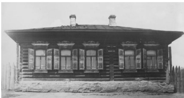
Рисунок Б.1 - Жилой дом в селе Усть-Абаканском по ул. Набережная, фото начала XX в.
