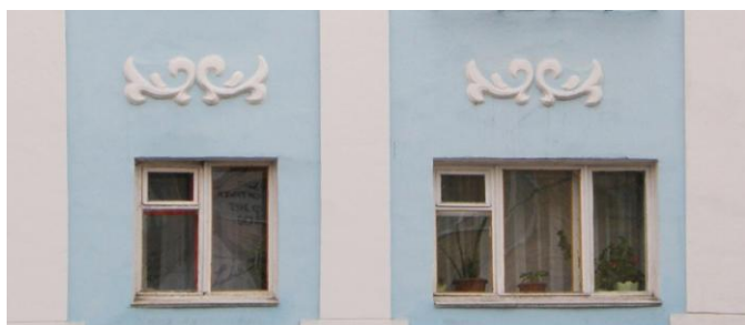
Рисунок Б.2 - Фрагмент оформления фасада жилого дома по ул. Щетинкина в Абакане, фото 2012 г.
