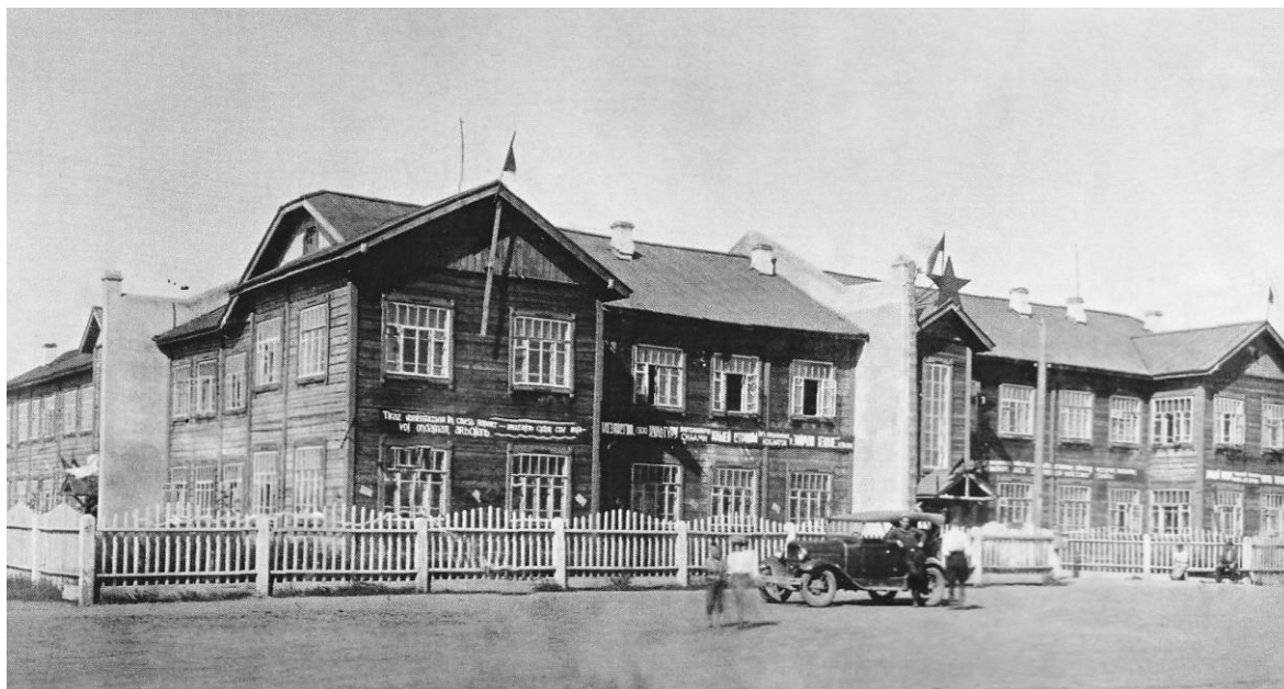
Рисунок Б.1 - Окружной исполком (Облисполком) в поселке станции Абакан, фото 1930-е гг.
