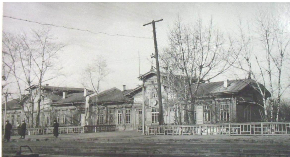
Рисунок Б.4 - Железнодорожный вокзал станции Абакан по ул. Вокзальная
