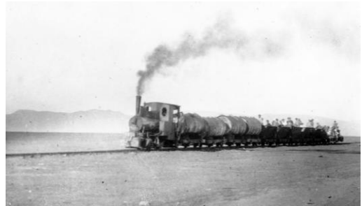
Рисунок Б.3 - Объект транспортной связи шахтерских поселений с пристанью Аскировской (узкоколейная железная дорога), фото 1911 г.
