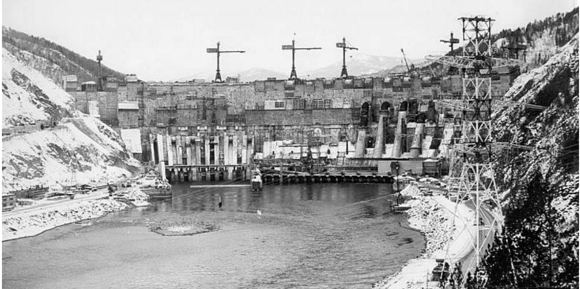
Рисунок Б.1 - Строительство Саяно-Шушенской ГЭС, фото 1970-х гг.
