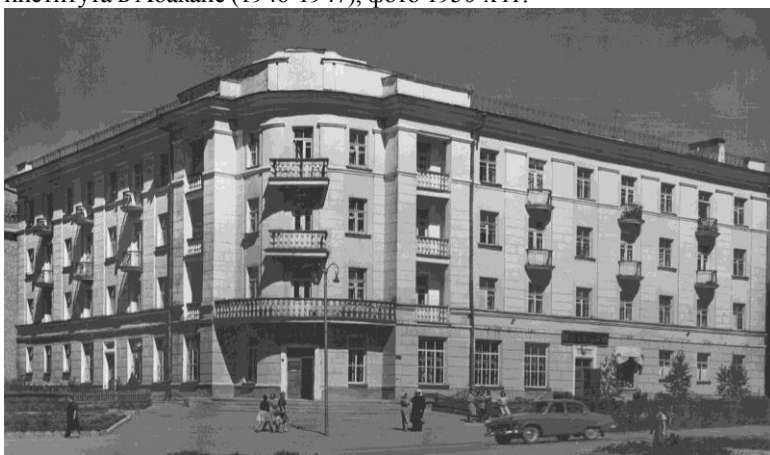
Рисунок Б.5 - Жилой дом с обслуживанием в Абакане, фото 1950-х гг.
