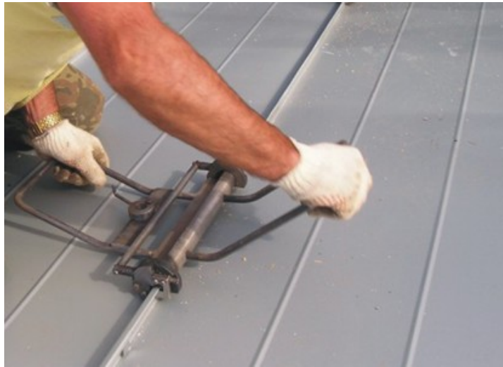
Рисунок 81 – Дозаккрытие фальцев рамками второго прохода
