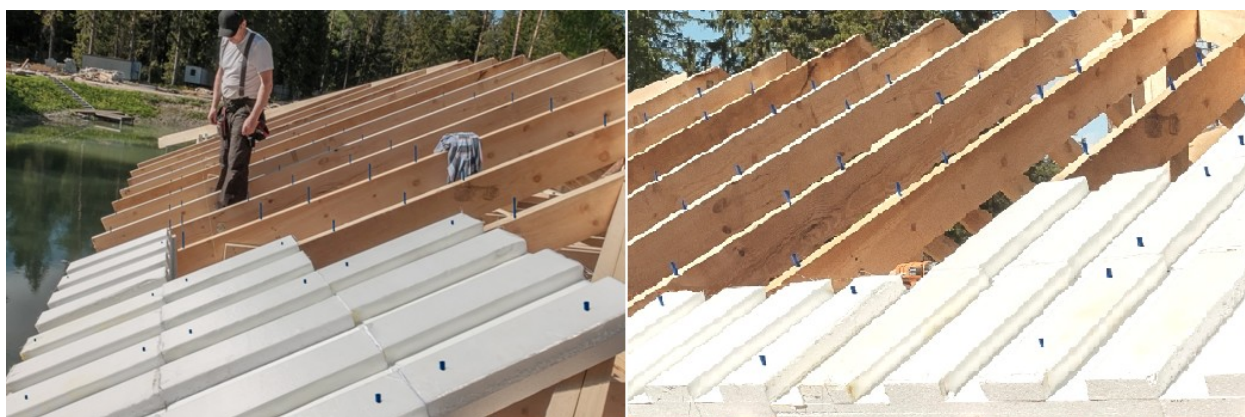
Рисунок 80 – Монтаж «термопанелей» на предварительно установленную дюбельную систему
