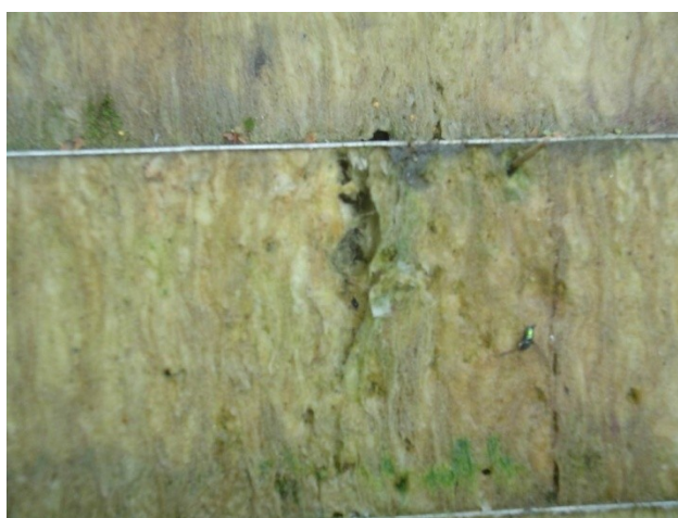
Рисунок 11 – Фотоснимок сэндвич панели с базальтовым волокном, через полтора года с момента установки
