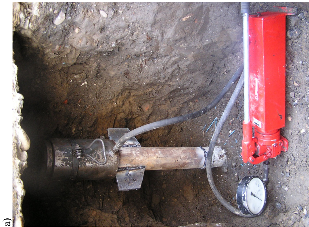
Рисунок 4.8 – Объединение отдельных инъекционных свай в единую конструкцию с существующим ленточным ростверком: а) включение инъекционной сваи в работу; б) оголовок инъекционной сваи
