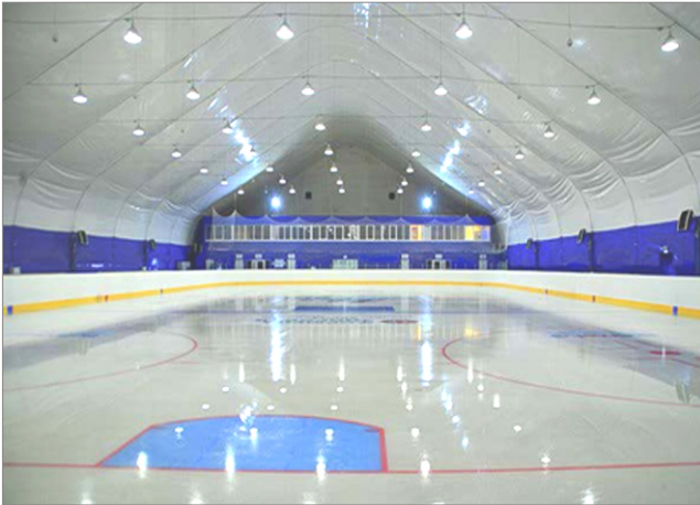
Рис. 38. Быстровозводимая кровля (тенто-каркасная конструкция). Хоккейная площадка «АйсБерг», Новгород, район (Россия). 2014 г.п. Компания тентовая архитектура «Tentmax» [ http://vk.com/club65184623 ].
