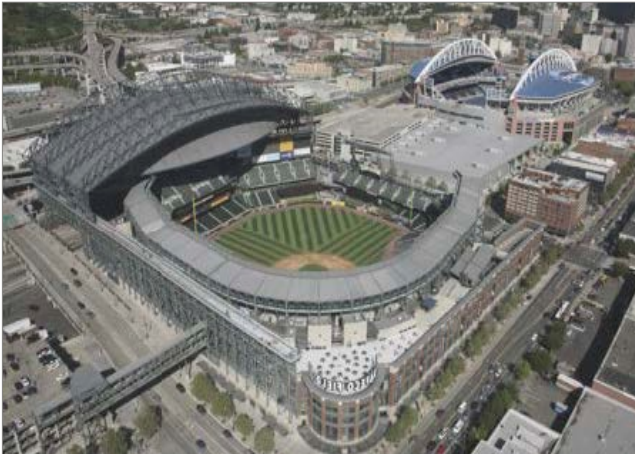
Рис. 50. Раздвижная кровля. Стадион «Safeco Field», Сэтл (США). 1999 г.п. Архит. компания «NBBJ», «360 Architecture» [ http://www.gwlocphoto.com/mlb-stadium-safeco-field-century-link-stadium ].
