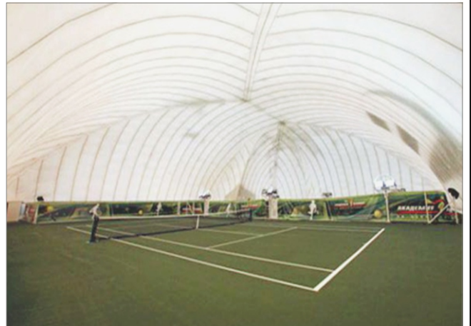
Рис. 41. Быстровозводимая кровля (воздухоопорная конструкция). Акад. тенниса им. Шамиля Тарпищева, Казань (Россия). 2010 г.п. Основатель: Пипия М.В. [ http://www.wayfit.ru/cat/217-akademiya_shamiya_tarpischceva_tennisnyi_kort.html ].
