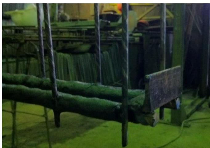
Рис. 4.3. Общий вид анкерного уголка на опоре балки
