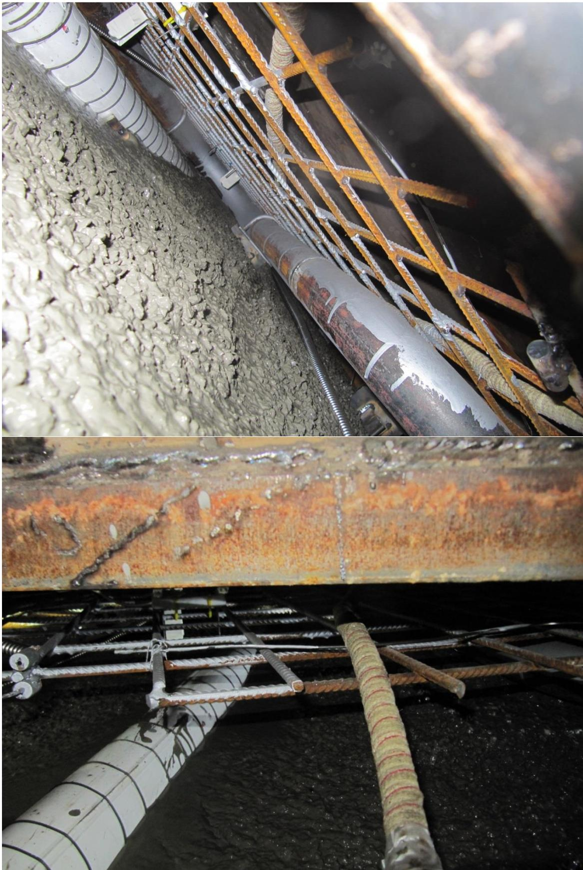
Рис.4.11 Продвижение бетонной смеси с уклоном в  $5^{\circ}$
