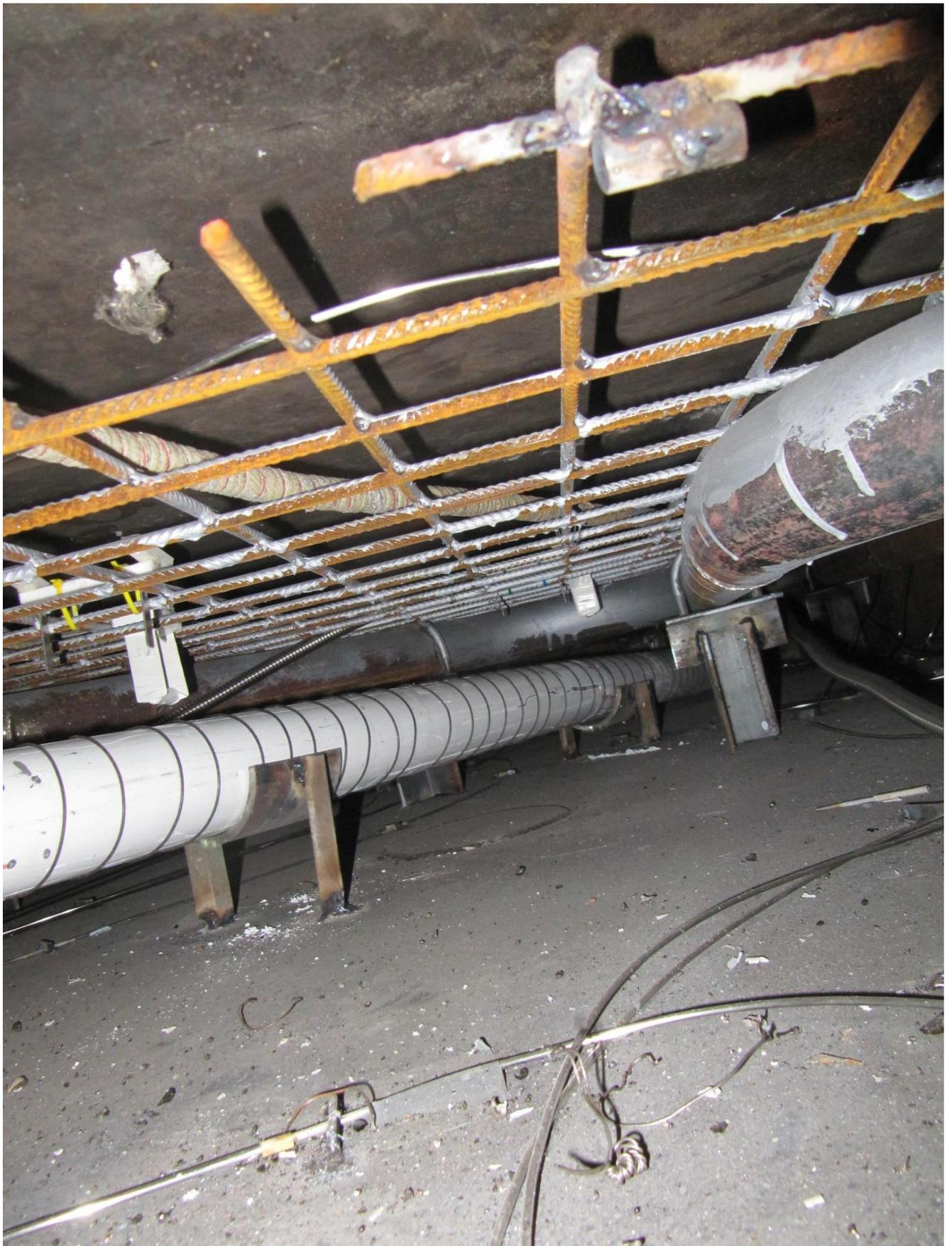
Рис. 4.5 Вид полости с торца до бетонирования, насыщение полости, бетоновод
