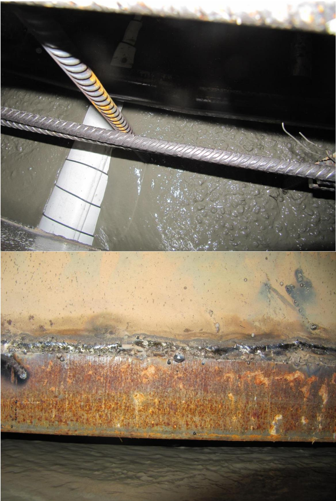
Рис. 4.12 Горизонтирование бетонной смеси после прохождения уровня труб разогрева и арматурной сетки
