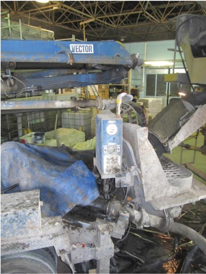
Рис. 4.8 Подача бетонной смеси в приемный бункер бетононасоса
