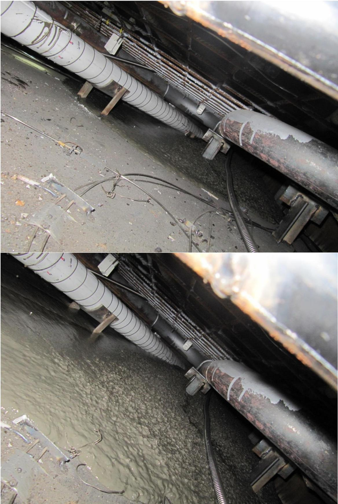
Рис. 4.10 Продвижение бетонной смеси с уклоном в  $10^{\circ}$
