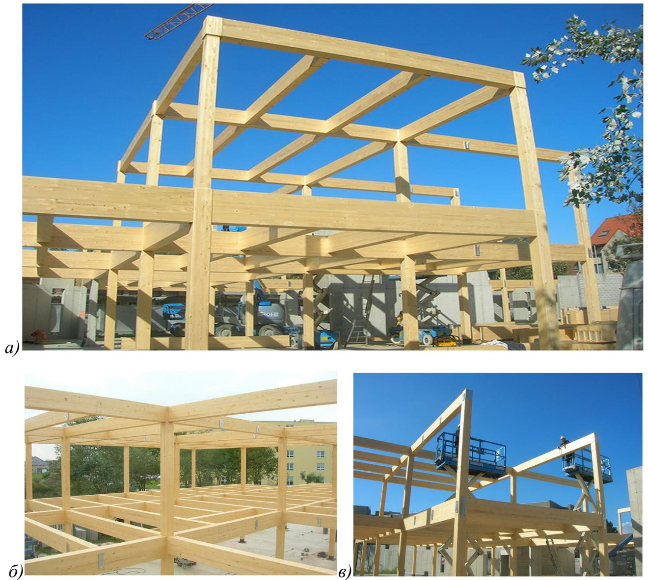
Рис. 1. 6. Школа для обучения медсестер в Люксембурге, год постройки 2011: а — общий вид стоечно-балочной конструкции; б — расположение соединения типа SHERPA ; в — сборка деревянных элементов
