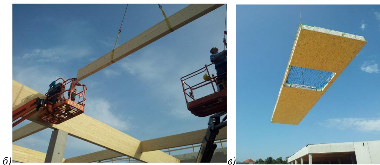
Рис. 1.8. Торговый комплексный центр в Нойфурте в Австралии, год постройки 2012 [74]: а)-б) монтаж второстепенной балки с главной; в— подвес несущей стены с проёмом
