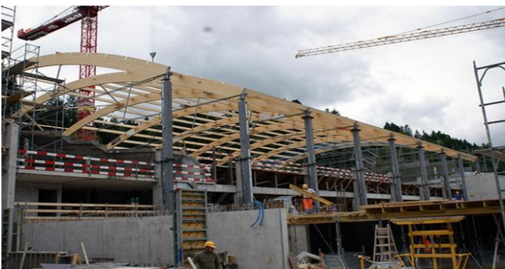
Рис. 1.9. Зал хоккейный в Швейцарии, год настройки 2012: а — общий вид конструкции крыши; б — внешний фасад; в — расположение соединения типа SHERPA
