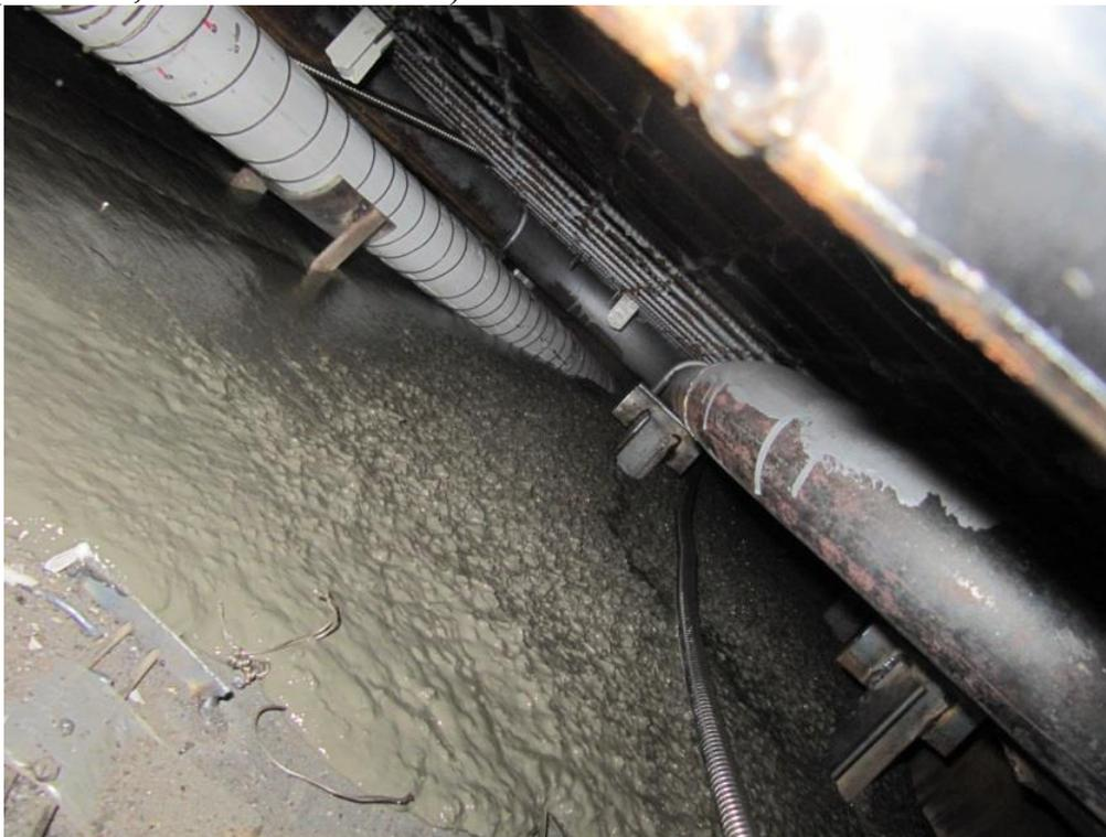
Рис. 10. Продвижение бетонной смеси с уклоном в  $15^{\circ}$
