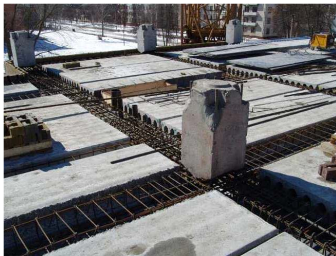
Рисунок 16 – Устройство перекрытия в системе АРКОС
