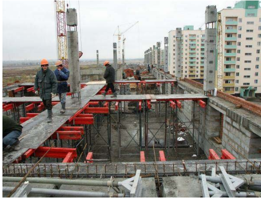
Рисунок 14 – Возведение каркаса «АРКОС»
