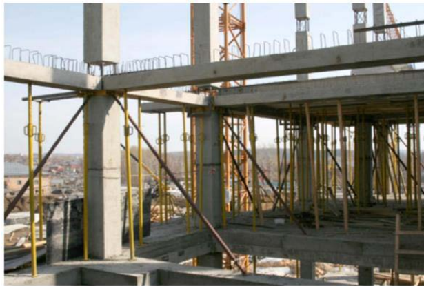
Рисунок 10 – Возведение каркаса «Рекон»
