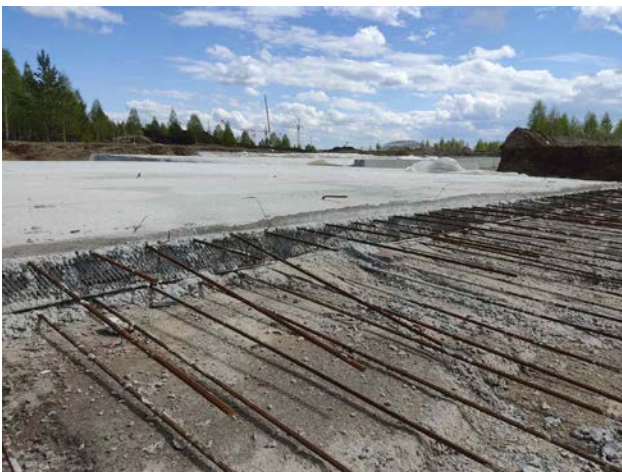
Рисунок 5 – Организация рабочего шва бетонирования в возводимой плите
