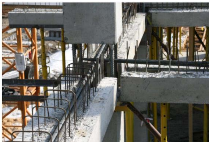
Рисунок 11 – Стык колонны и ригеля в системе «Рекон»
