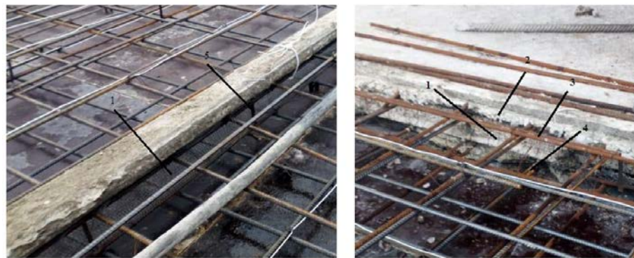
Рисунок 8 – Конструкция рабочего шва с металлотканой сеткой:
