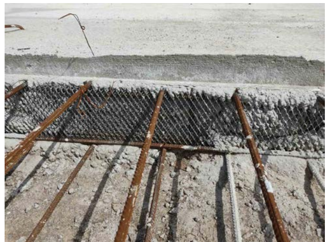
Рисунок 5 – Организация рабочего шва бетонирования в возводимой плите
