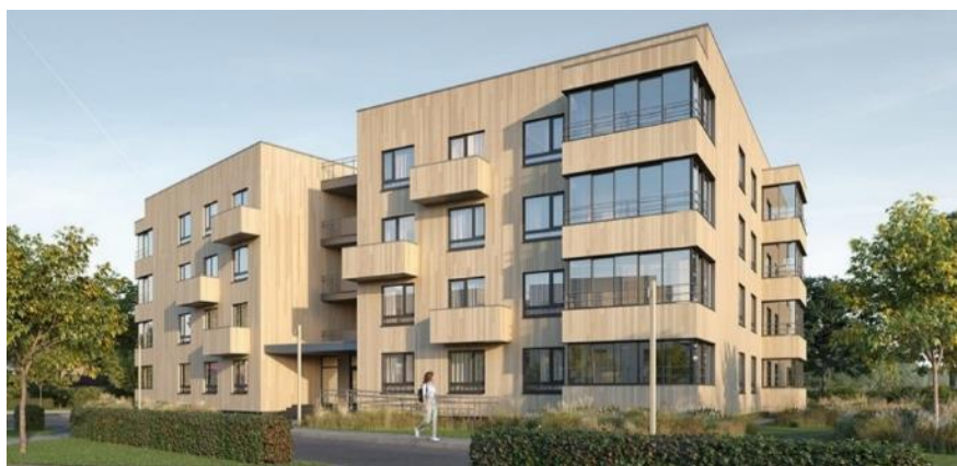
Рисунок 3.4 – Многоквартирный жилой дом из ДПК панелей в городе Сокол.
