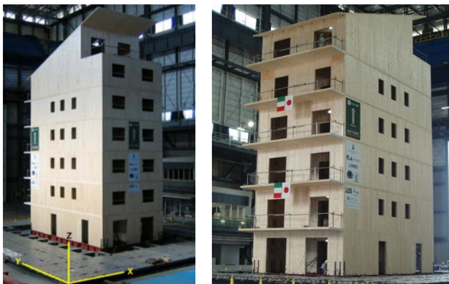
Рисунок 2.9 – 7-этажное здание из ДПК панелей на испытательном стенде, расположенном в Мики, Япония [202]
