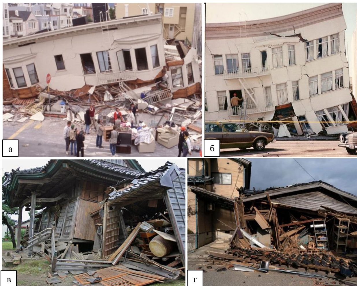
Рисунок 1.16 – Разрушение деревянных зданий после землетрясений: а, б - Землетрясение Лома-Приета, США, 1989; в, г – Землетрясение после тайфуна Ман-Үі, Япония, 2007
