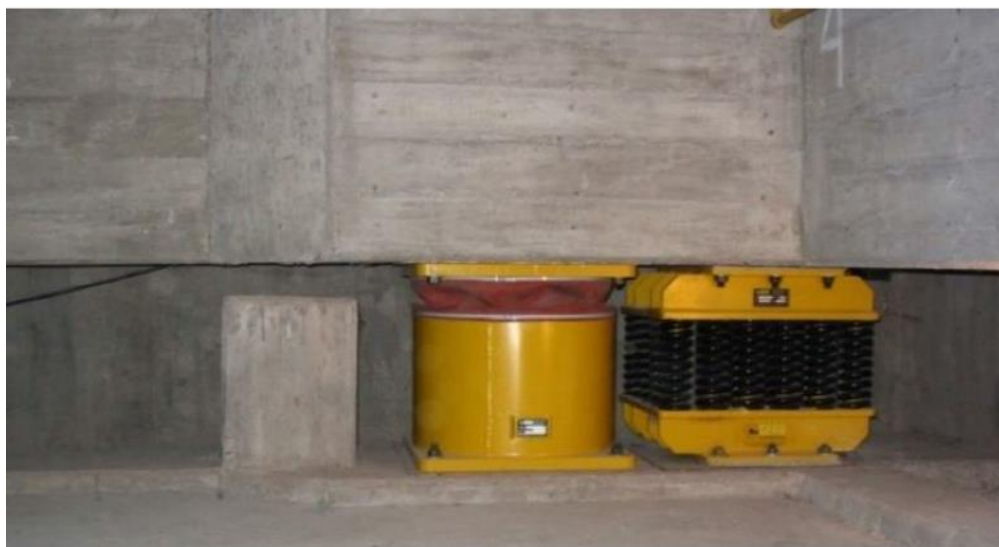
Рисунок 1.14 – Установка ТПДС при параллельном размещении блока витых пружин и вязкоупругого демпфера [16]
