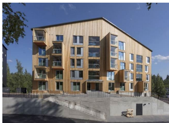
Рисунок 1.7 – Здание жилого комплекса «Puukuokka», Финляндия
