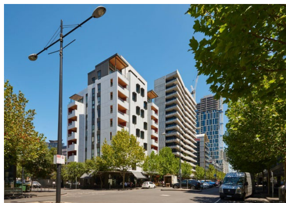
Рисунок 1.9 – Здание жилого комплекса «Forte», Австралия
