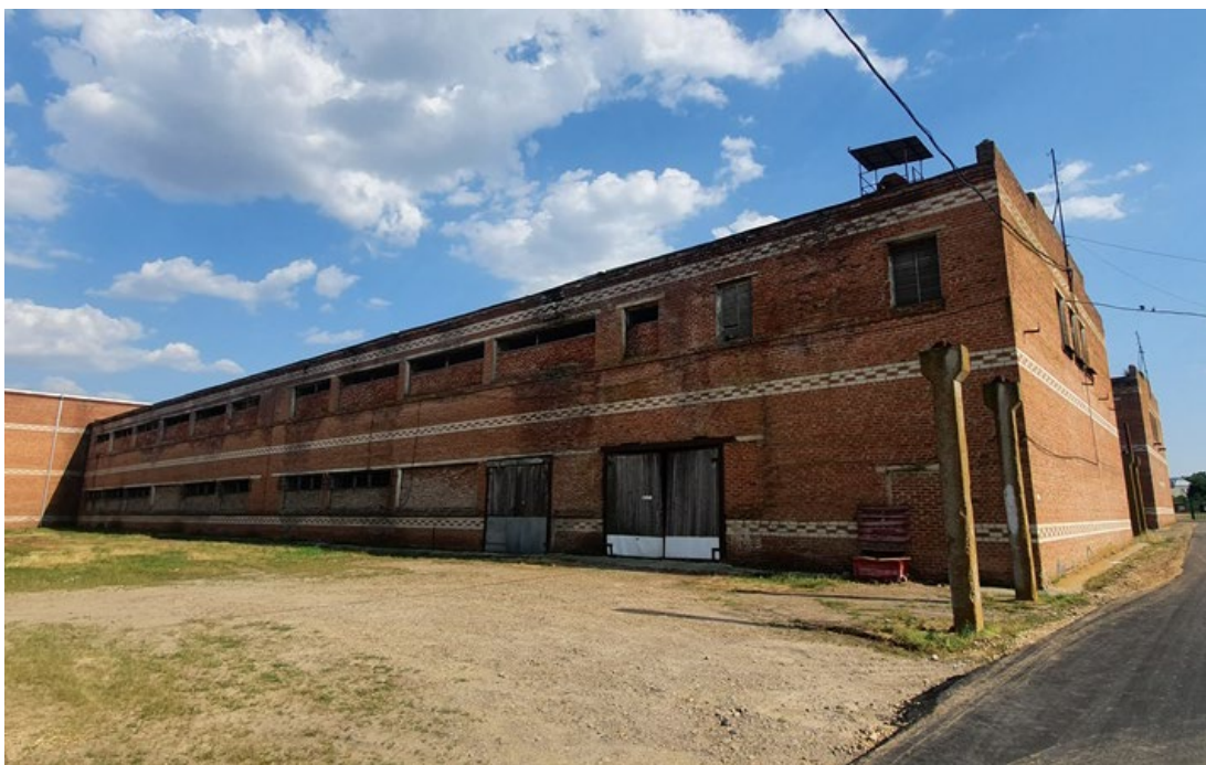
Рисунок 4.13 – Общий вид обследуемого здания клиники №5 предприятия «Армавирская биологическая фабрика»
