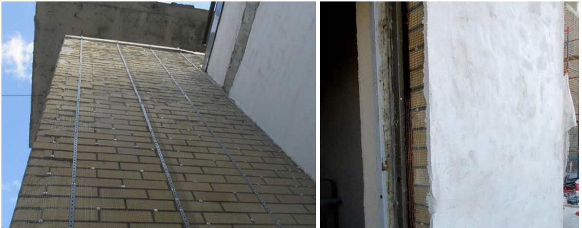
Рисунок 76 Иллюстрации к процессу нанесения модифицированного штукатурного состава, Санкт-Петербург, ул. Шкапина, д. 9
