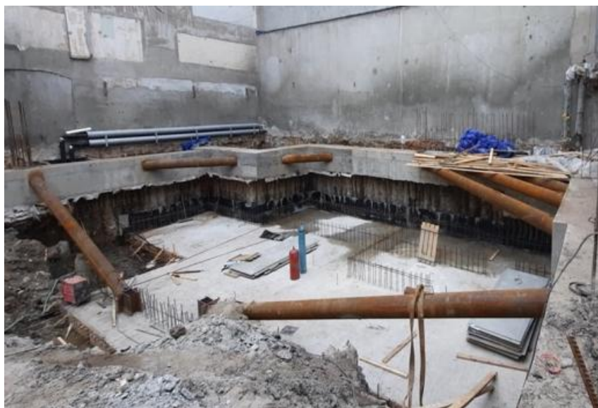
Рисунок 4.4. Общий вид участка строительства на этапе разработки центральной части котлована под защитой системы раскрепления ограждения.
