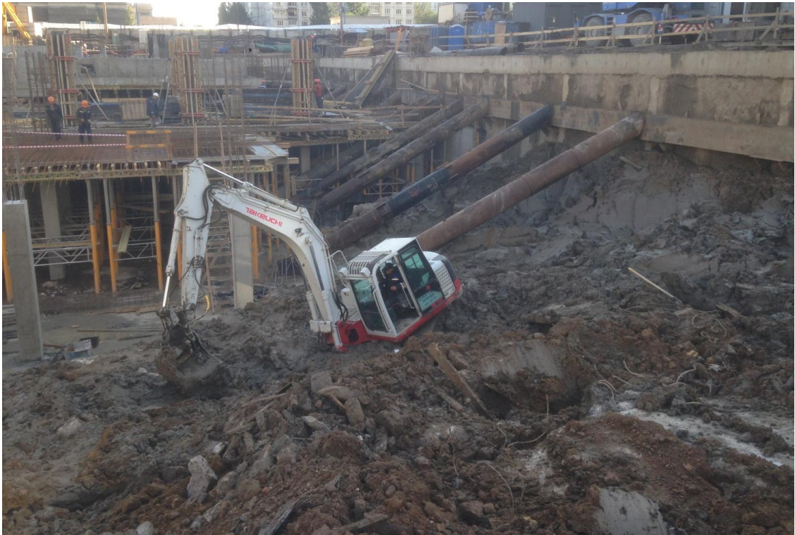
Рисунок 4.28. Разработка грунта котлована под защитой только верхнего яруса распорной системы.
