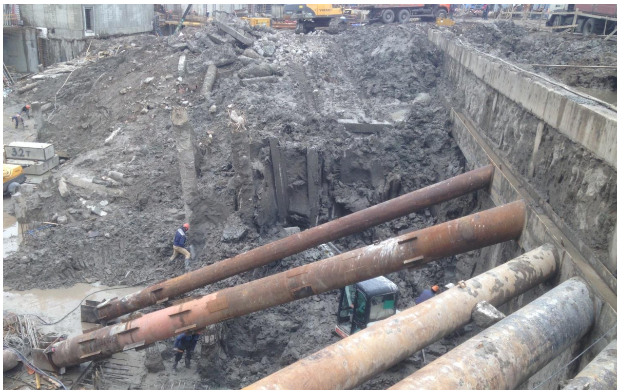
Рисунок 4.29. Нарушение последовательности производства работ, полная экскавация грунтовых берм на не раскреплённом участке стены в грунте.
