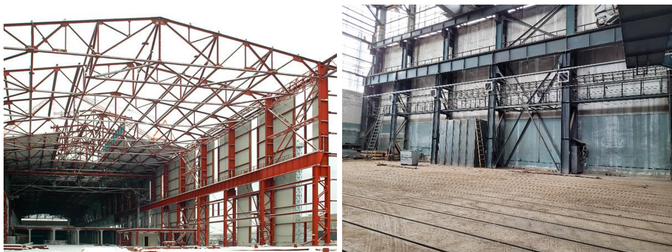
Рисунок 1.1 Примеры использования решетчатых сквозных конструкций
