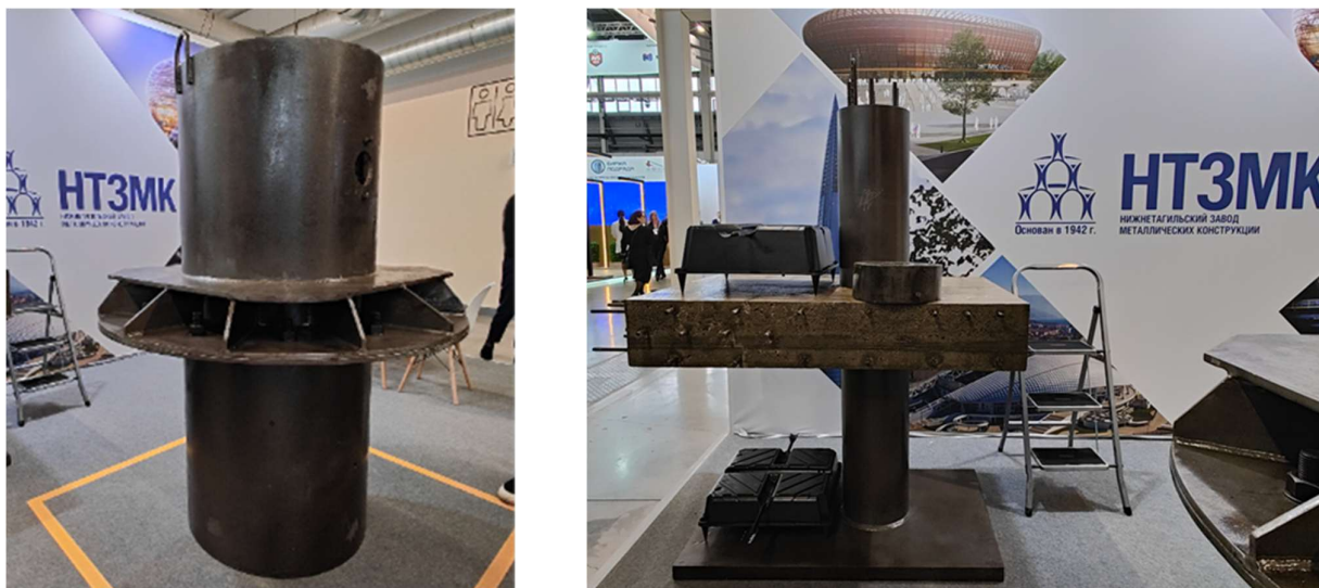
Рисунок 1.5 – Конструктивные решения стыка с перекрытием НТЗМК (фото автора)
