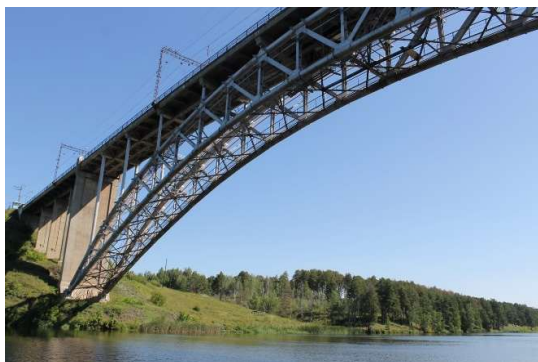
Рисунок 1.1 – Трубобетонные мосты: а) мост через р. Исеть [23], б) мост Г.П. Передерия через р. Неву [120]
