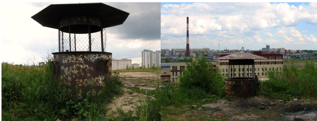
Рисунок 1.2 – Газодренажные скважины полигона ПО «Приморская свалка» г. Санкт-Петербурга
