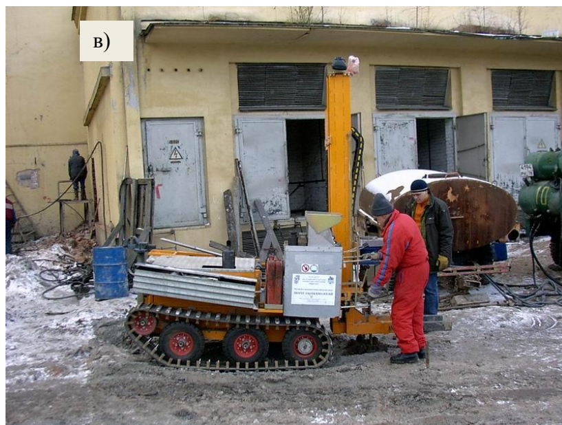
Рис. 4.32. Исследование уплотнения околосвайного грунтового массива при изготовлении свай DDS строительной площадке по адресу: Санкт-Петербург, пл. Островского, д.2: а) вид диаграммы исследуемых параметров; б) схема точек зондирования; в) вид установки RIG Geotech 204D
