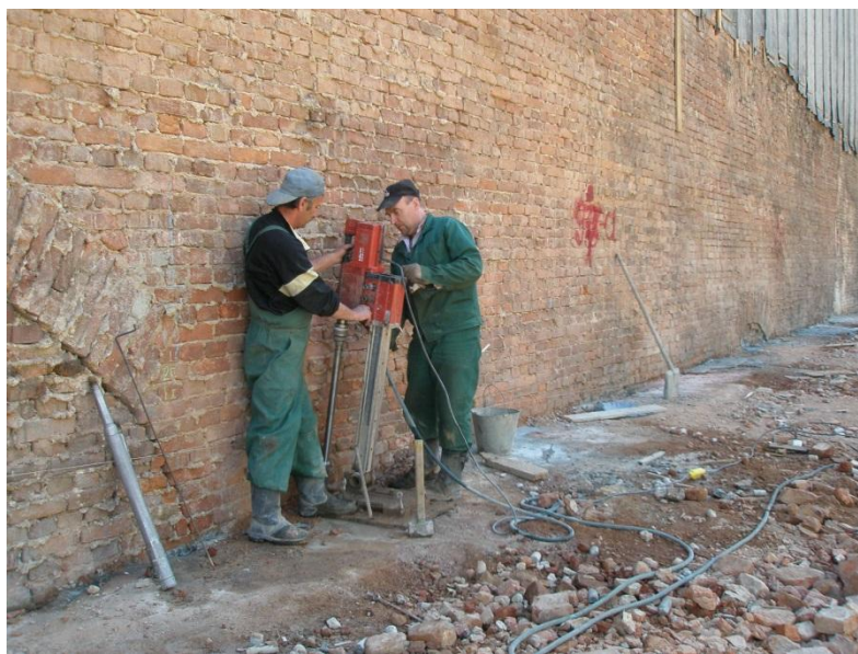
Рис.3.40. Устройство буровых скважин для инъекционного укрепления фундамента и грунтов основания в контактной зоне
