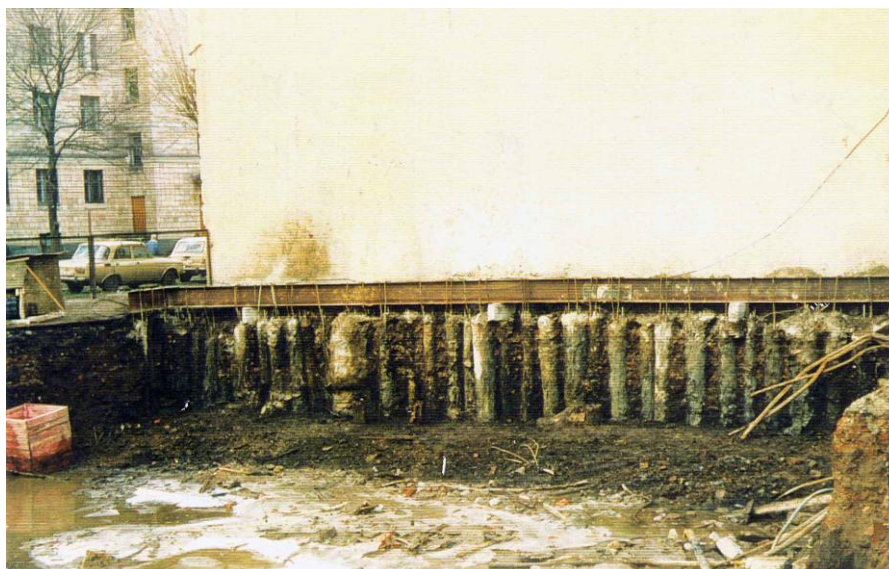
Рис. 3.20. Вид разделительной стенки (А.с. RU 0094007986 Бронин В.Н., Осокин А.И., Хурамшин Р.Я., 1995) на объекте в Адмиралтейском районе Санкт-Петербурга
