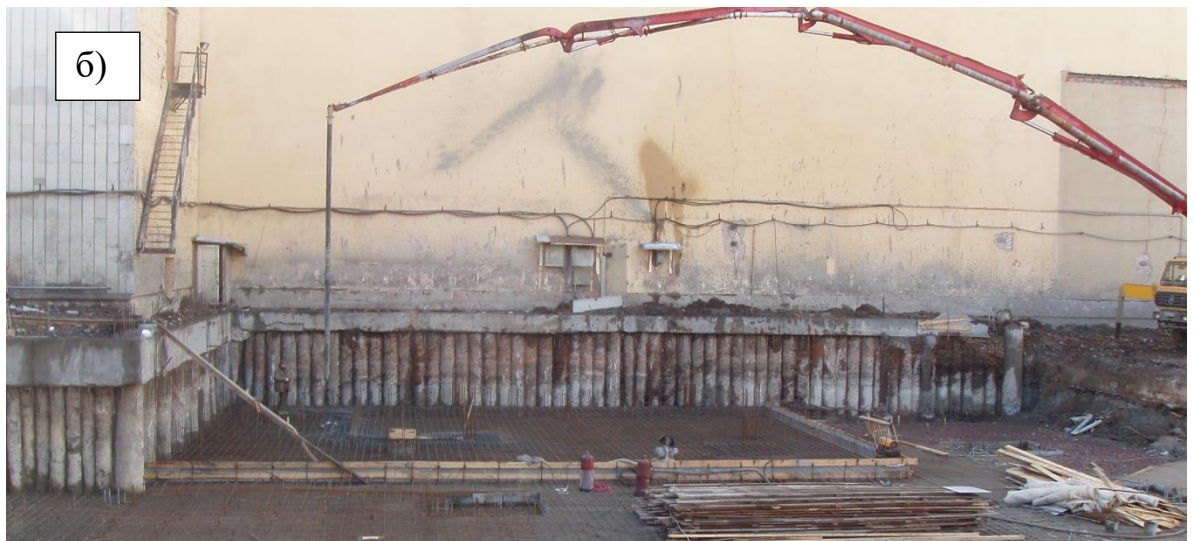
Рис. 2.10. Применение разделительного шпунта
