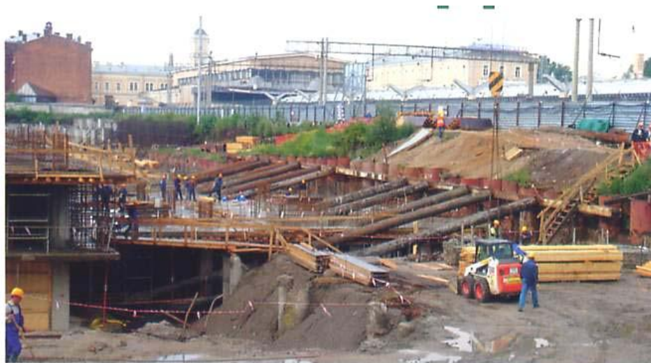
Рис. 1.5. Вид котлована ТРК «Галерея» с двумя уровнями металлических подкосов со стороны железнодорожных путей Московского вокзала при разработке котлована.
