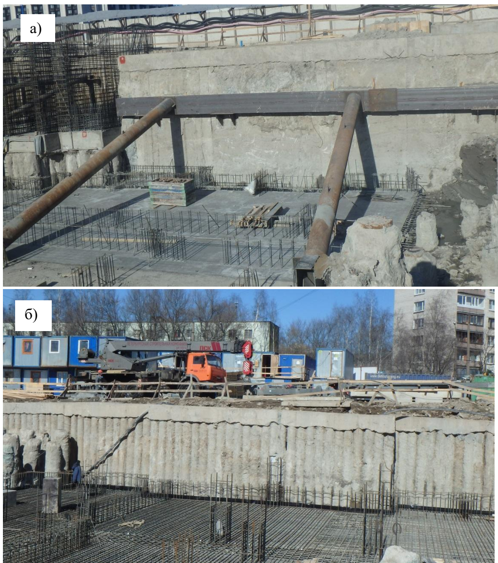
Рис.3.32. Вид котлована строительства ЖК «Огни Москвы» на ул. Костюшко, д.19а на участке с устройством ограждения с использованием конструкции «стена в грунте»(а) и секущихся свай (б)
