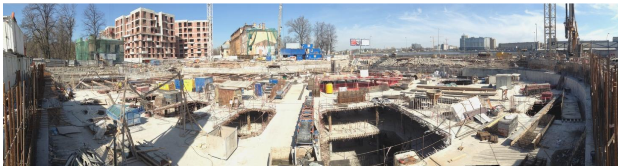
Рис.7.9. Общий вид площадки строительства
