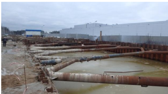
Рис. 2.23. Вид котлована на момент проведения технического обследования (март 2017 г.) (а) и деформации шпунтового ограждения (б).
