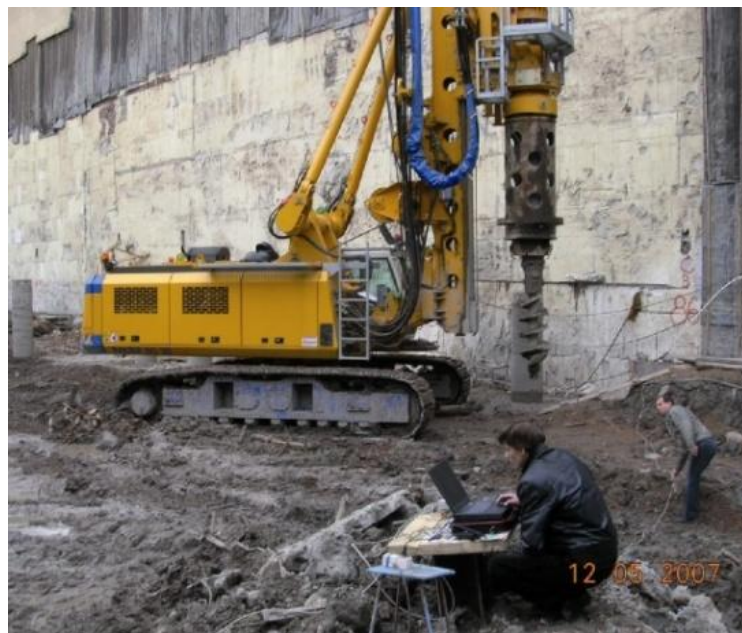
Рис. 3.42. Измерение вибродинамического уровня при устройстве буронабивных свай
