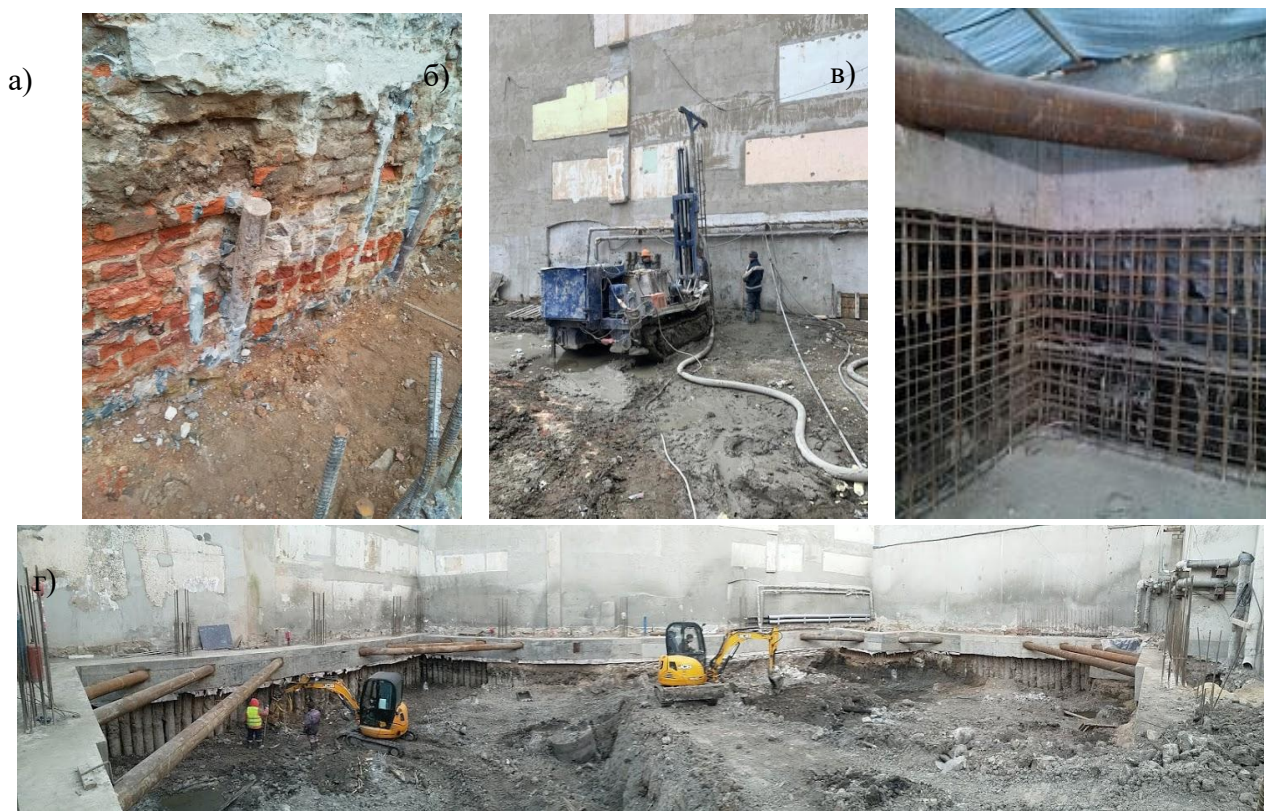
Рис.5.22. Этапы выполнения геотехнических работ на площадке при их геотехническом сопровождении: а) усиление фундаментов инъекцией манжетных колонн; б) устройство буроинъекционных свай усиления; в) армирование прижимных стен к ограждению котлована; г) откопка котлована.
