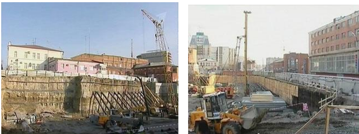
Рис. 2.17. Вид котлована с подкосами для исключения аварийного обрушения стенки
