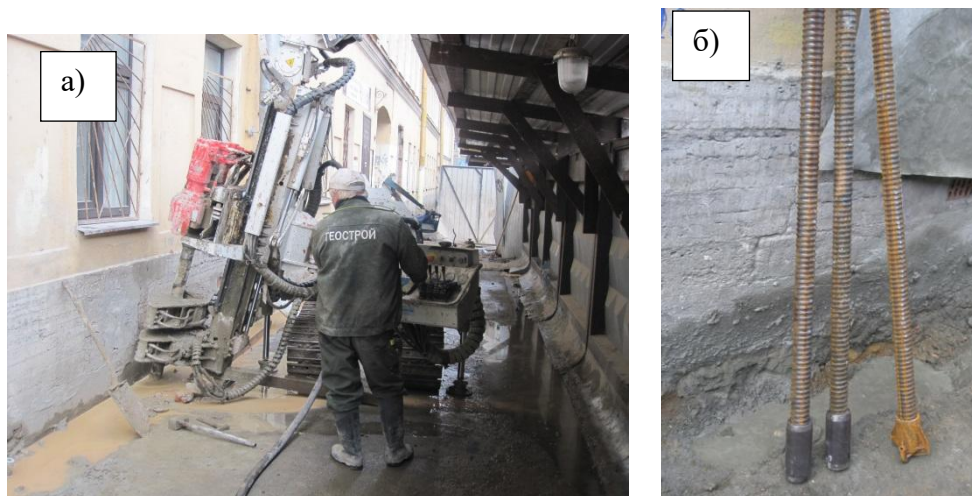
Рис. 6.17. Вид бурового станка СОМАСЧИ- 400Р в работе (а) и вид несущего элемента буринъекционной сваи с муфтами и буровым наконечником (б)
