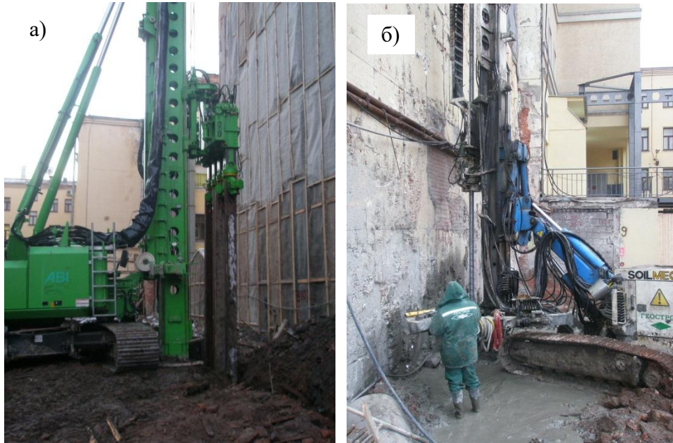
Рис.3.41. Вдавливание шпунта Алселор AZ установкой Банут 655 (а), устройство ограждающей конструкции котлована из буровых свай вдоль здания гостиницы (б)
