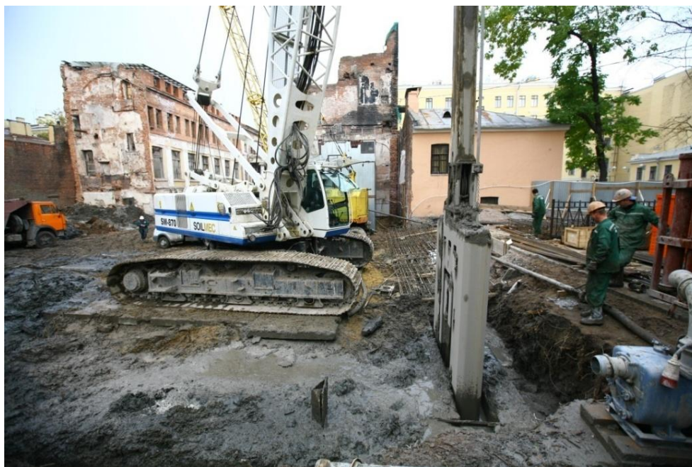
Рис. 8.24. Устройство конструкции ограждения котлована «стена в грунте» на участке строительства подземной части.
