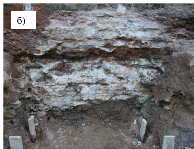
Рис. 3.39. Вид кладки фундамента из гранитных валунов (а), вскрытый для технического обследования участок бутового фундамента после закрепления инъекцией(б).
