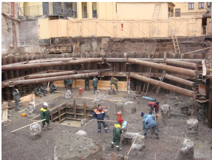
Рис.3.43. Вид котлована для устройства подвального этажа д. 55 по Невскому пр.
