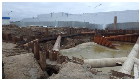
Рис. 2.23. Вид котлована на момент проведения технического обследования (март 2017 г.) (а) и деформации шпунтового ограждения (б).
