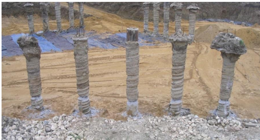
Рис. 4.22. Вид откопанных свай «Атлас» в слабых грунтах
