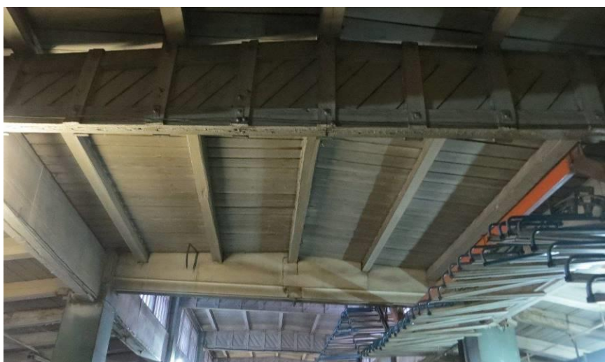
Рисунок 1.5. Дощато-гвоздевые балки в покрытии промышленного здания.
