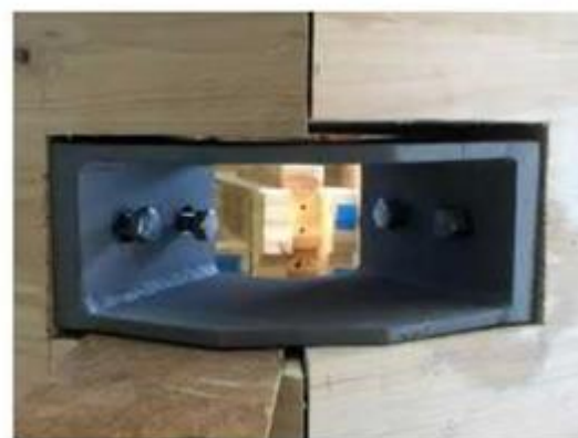
Рисунок 1.10. Соединение CLT-панелей под углом с помощью коннектора
