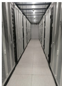
Рисунок 1 – Машинный зал ЦОД в г. Санкт-Петербург: а – план машинного зала: С1-С24 – стойки с серверным оборудованием, К – кондиционеры, К р – резервные кондиционеры; б – «горячий» коридор над которым установлены потолочные панели; в – «холодный» коридор; г – серверное оборудование в стойке; д – расположение точек измерения и датчика температуры воздуха, входящего в стойки
