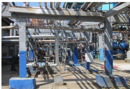
Рисунок 16 – Внешний вид конструкций эстакады
