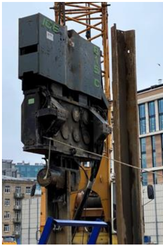
Рисунок 2.20 Используемый вибропогружатель (а); Установка приборов на исследуемую сваю (б).
