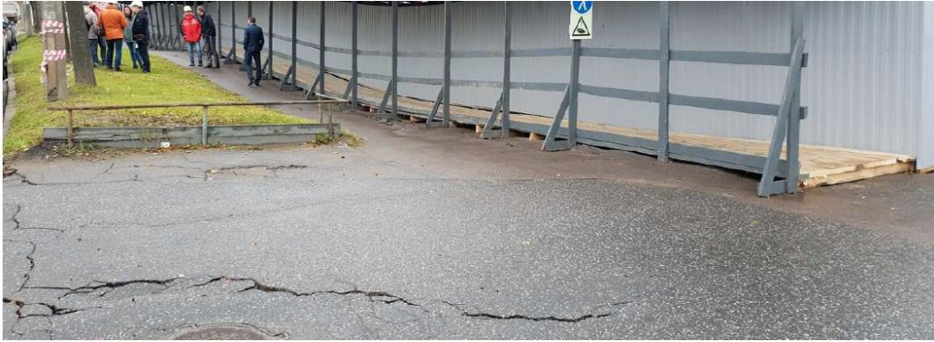
Рисунок 1.29 Просадка массива грунта в процессе вибропогружения шпунтовых свай
