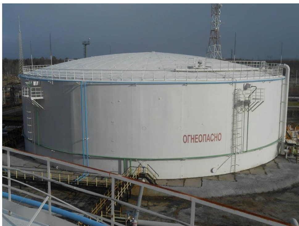
Рисунок 1.2 – Общий вид вертикального стального резервуара ёмкостью 20 тыс. м 3
