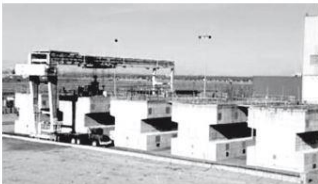
Рисунок 1.7 – Модуль «Macstor» на АЭС Gentilly, Канада [74]
