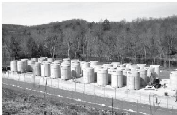
Рисунок 1.5 – Контейнерное хранилище на открытой площадке [74] и в здании [21]
