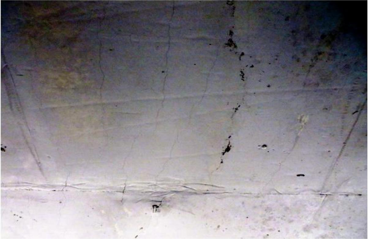
Рисунок 4.4 – Трещины в средней части пролета сооружения
