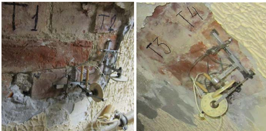
Рисунок 4.1.2 – Установка тензометров T1÷T4
