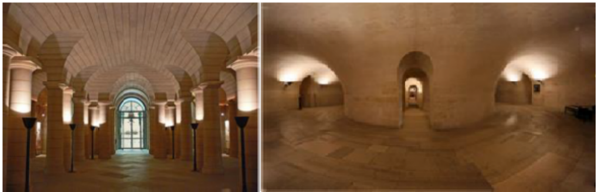
Рисунок 1.1.8 – Париж. Храм Св. Женеьевы. Цокольный этаж. Перекрытия с использованием многосоставного коробового свода и кольцевого цилиндрического свода на центральной опоре (Фото Клименко Ю.Г. 2006 г.) [67]
