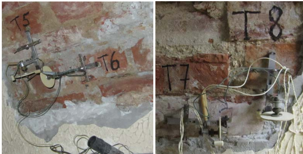
Рисунок 4.1.3 – Установка тензометров T5÷T8
