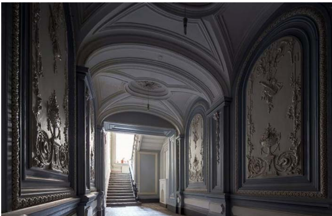
Рисунок 1.1.6 – Парадная жилого дома, ул. 8-я Красноармейская, дом 5 [178]
