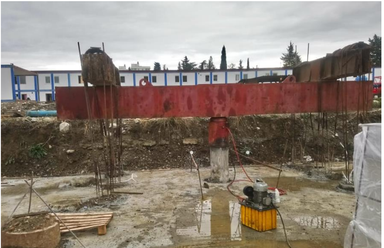
Рисунок 4.5 – Общий вид установки для проведения полевых испытаний натуральных свай
