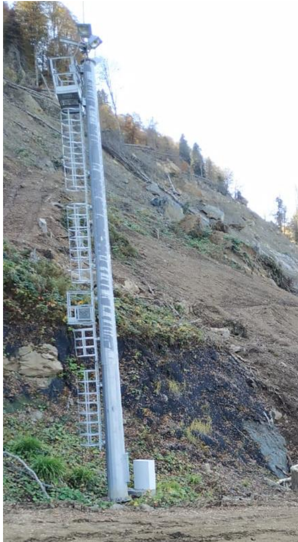
Рисунок 4.7 – Осветительная мачта высотой 35 м на свайном фундаменте из буринъекционных конических свай
