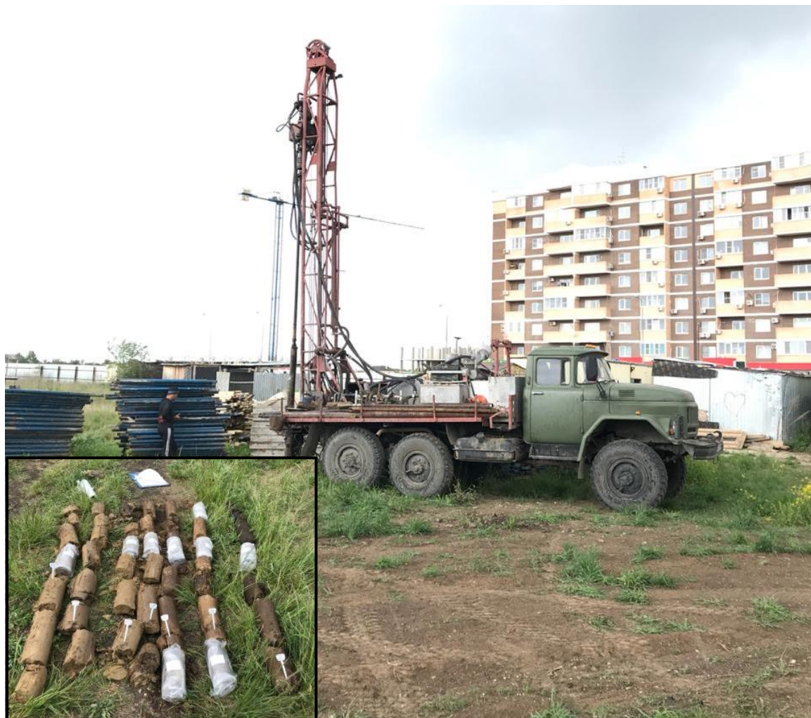
Рисунок 4.3 – Инженерно-геологические изыскания на площадке проведения полевых испытаний буроинъекционных свай
