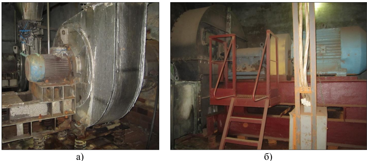
Рис. 3.31. Дутьевые вентиляторы: а) ВДН-10; б) ВД-15,5
