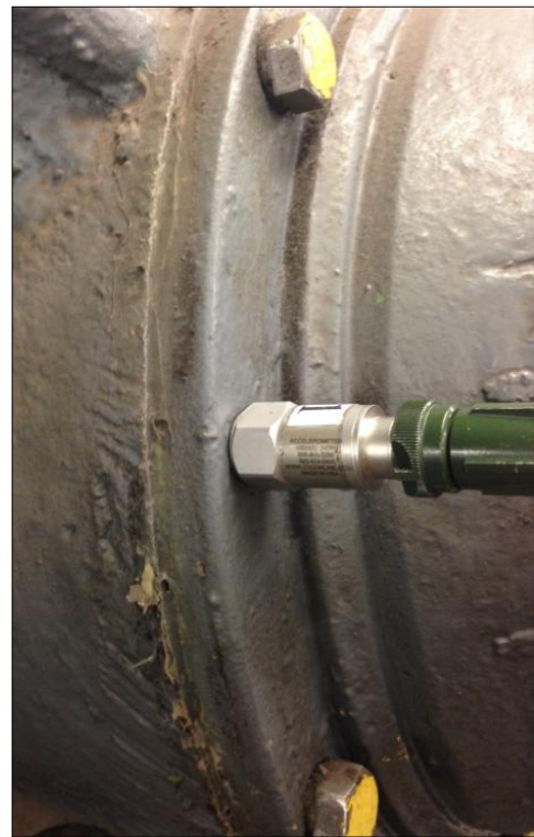
Рис. 3.9. Установка датчика с помощью переходной шпильки
