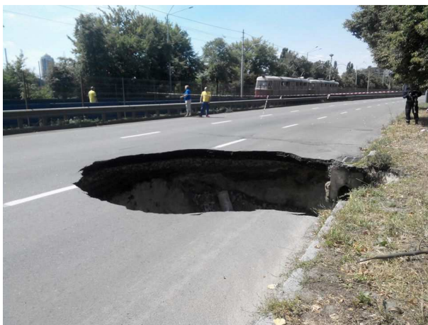
Рисунок 1.4 – Провал дневной поверхности земли из-за разрушения подсводной части канализационного коллектора
