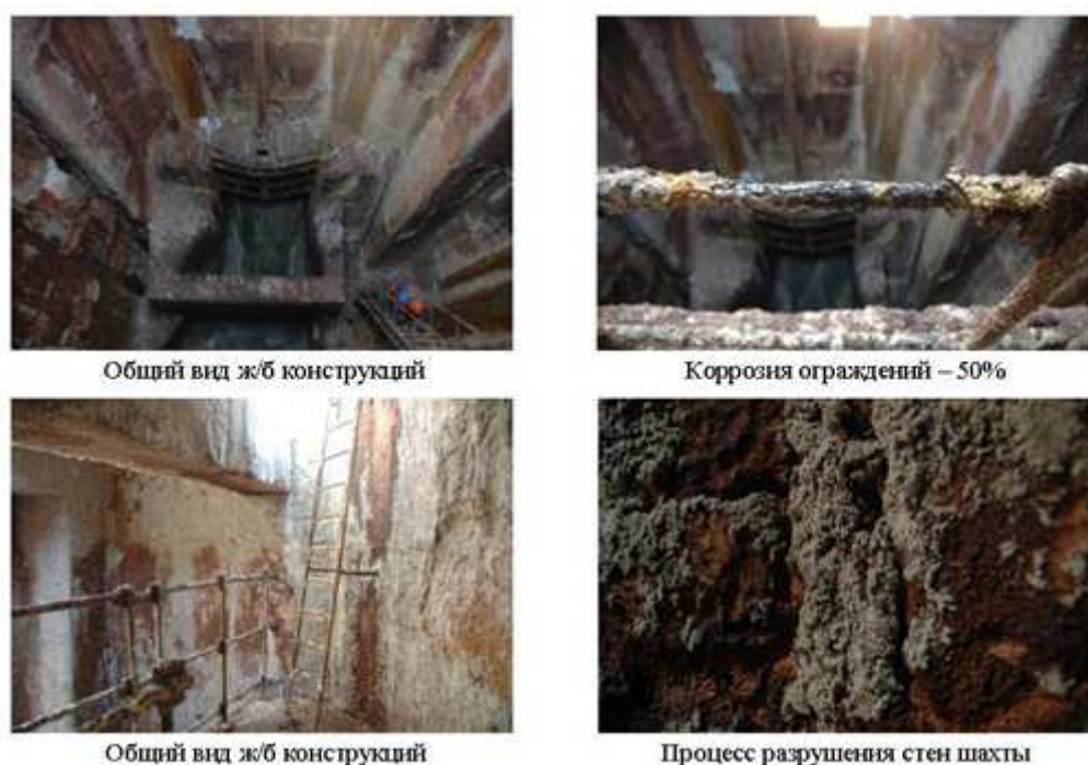
Рисунок 1.17 – Фотофиксация состояния шахты № 10, расположенной на дублере канализационного коллектора в районе пл. Мужества в Санкт-Петербурге
