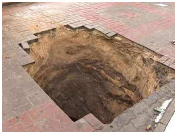
Рисунок 1.4 – Провал дневной поверхности земли из-за разрушения подсводной части канализационного коллектора
