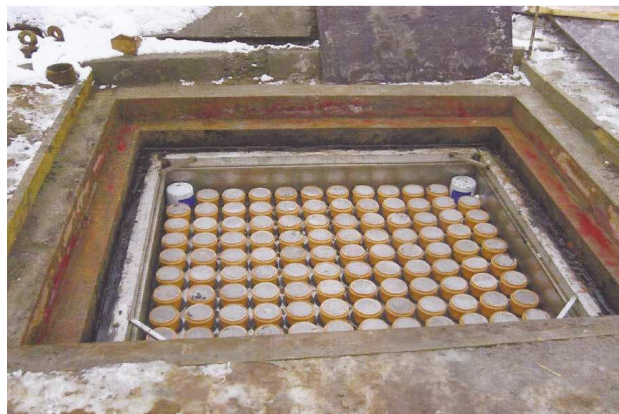
Рисунок 1.16 – Установка ОПВС в шахте главного канализационного коллектора северной части в Санкт-Петербурге
