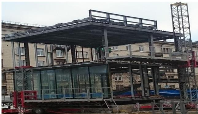
Рис. 16. Моделирование и строительство типового образца модуля УВСС технологии скоростного монтажа полносборных зданий
