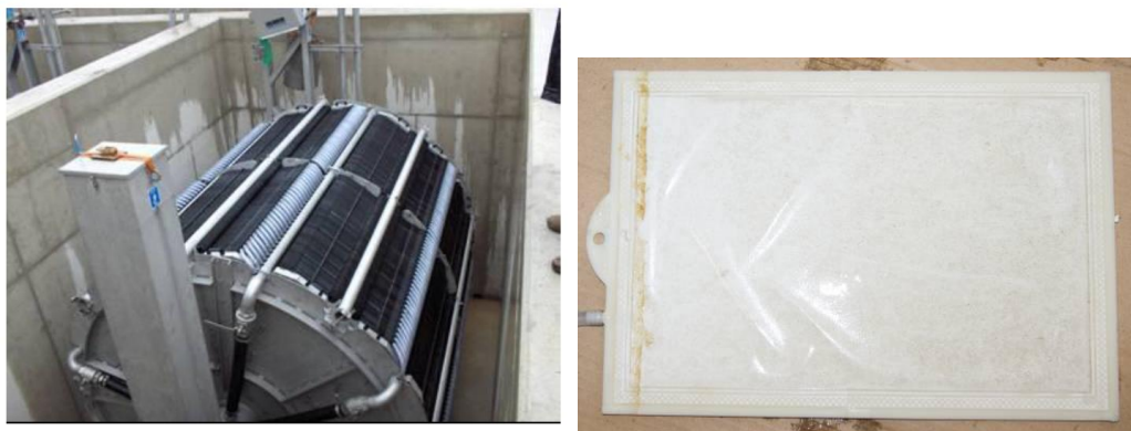
Рисунок 4.1 – Мембранный модуль с плоскораменными мембранами фирмы HUBER(слева) и плоскораменная мембрана SINAR (справа).
