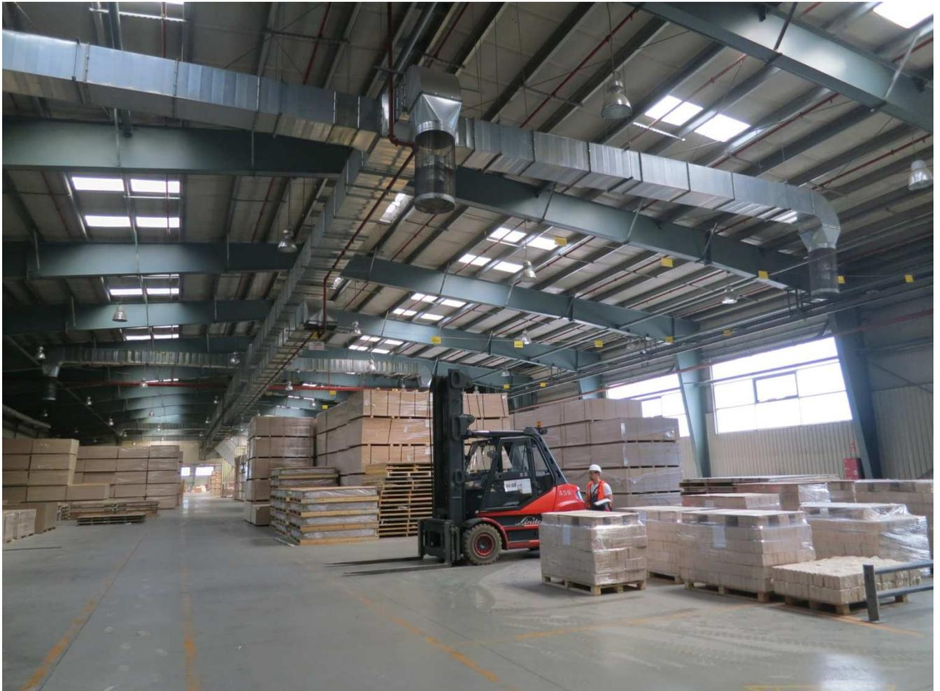
**Рисунок 1.1.** Каркас из рам переменной жесткости здания складского назначения
