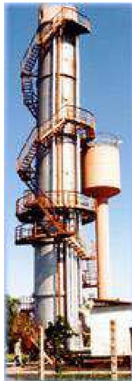
Рисунок 1.9 - Аэротенк колонного типа
