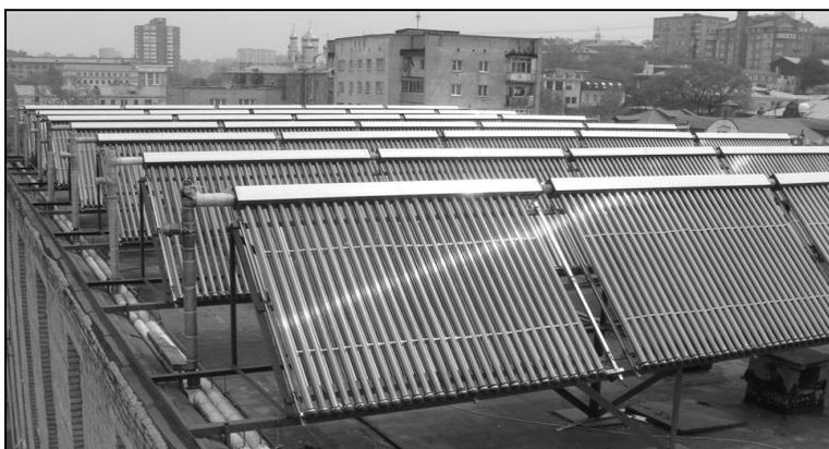
Рисунок 7 – Размещение и обвязка солнечных коллекторов СВНУ на крыше здания кампуса ДВФУ
