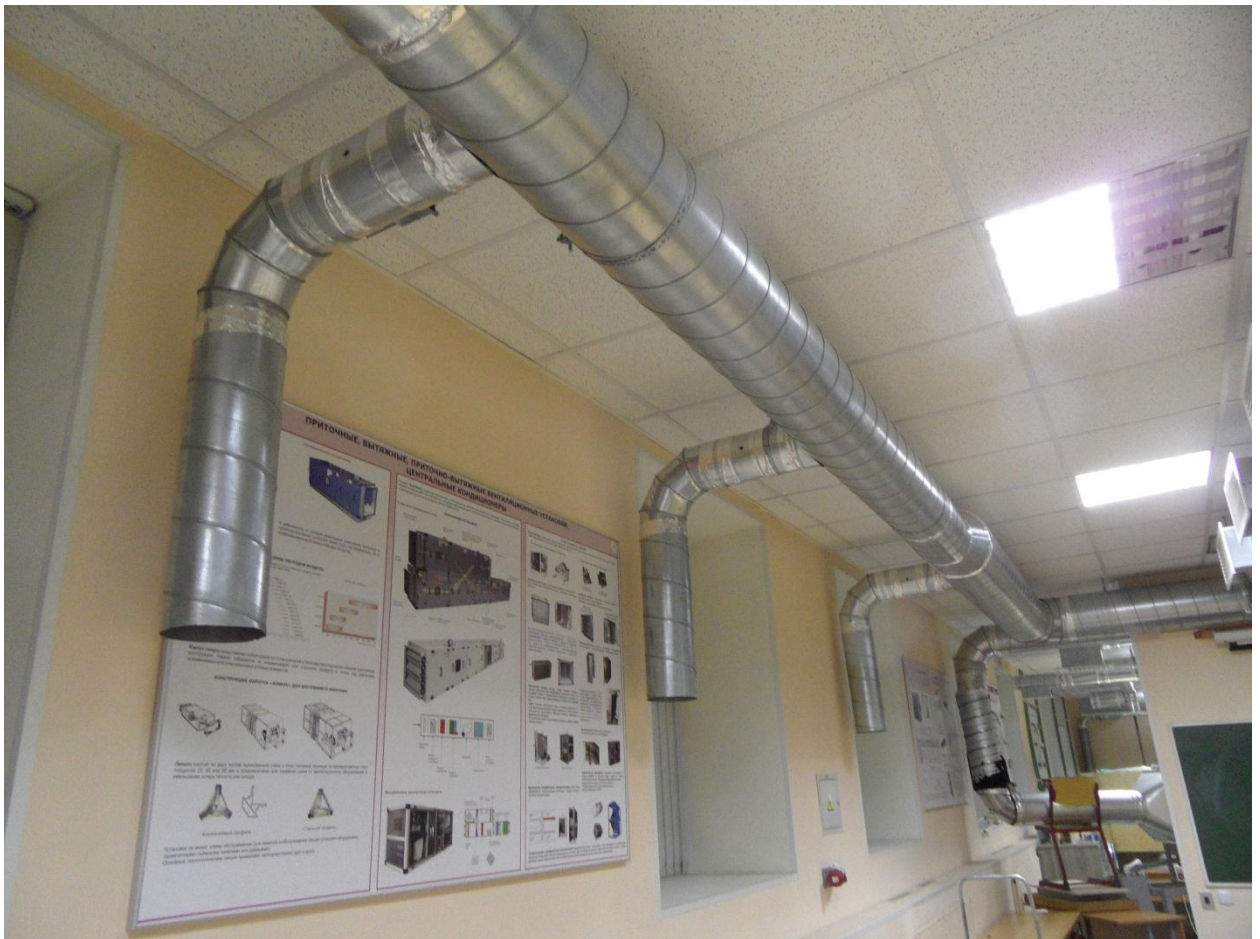
Рисунок 4.15 – Система воздуховодов лаборатории с опытной установкой
