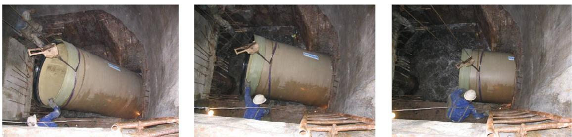
Рисунок 2.2.1 – Введение трубы «Hobas» в реконструируемый коллектор
