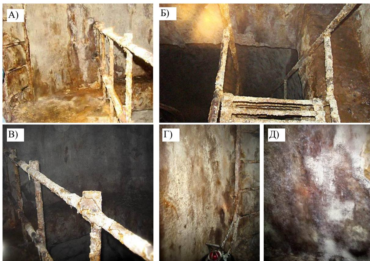
Рисунок 1.3.3.7.2 – Результаты осмотра конструкций шахты №122А
