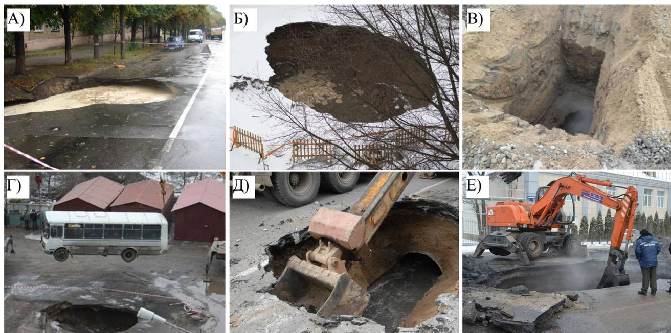
Рисунок 1.1.2 – Фотографии разрушений, вызванных обрушением канализационных коллекторов на территории бывшего СССР в последние годы
