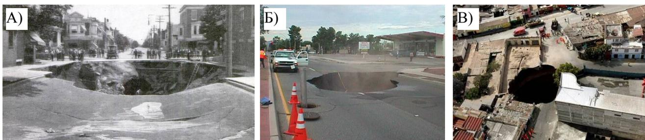
Рисунок 1.1.1 – Разрушения, вызванные прорывом канализационных коллекторов
