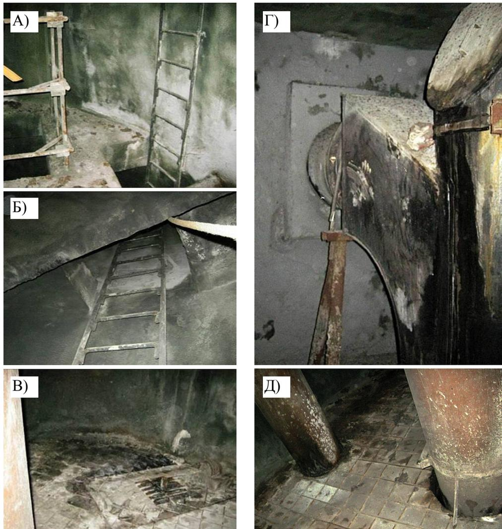
Рисунок 1.3.3.6.2 – Результаты осмотра конструкций шахты №122Б выше металлического перекрытия
