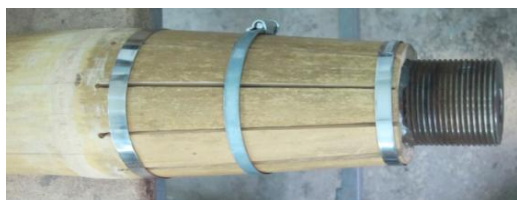
Рисунок 16 – Установка внутренней конической трубки в бамбук
